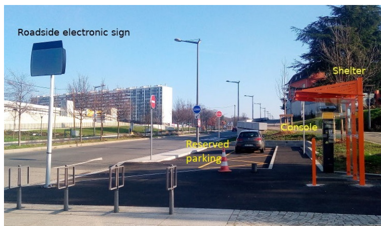
Figure 1.3 – Configuration d’un arrêt de covoiturage connecté. La structure orange ressemble à un abribus. Le passager informe les conducteurs potentiels de sa demande de covoiturage à l’aide de la console, demande qui est ensuite affichée sur le panneau électronique lumineux au bord de la voirie. Un conducteur peut récupérer le passager en toute sécurité sur la place de stationnement réservée à cette occasion. Photographie reproduite avec l’autorisation d’Ecov.
