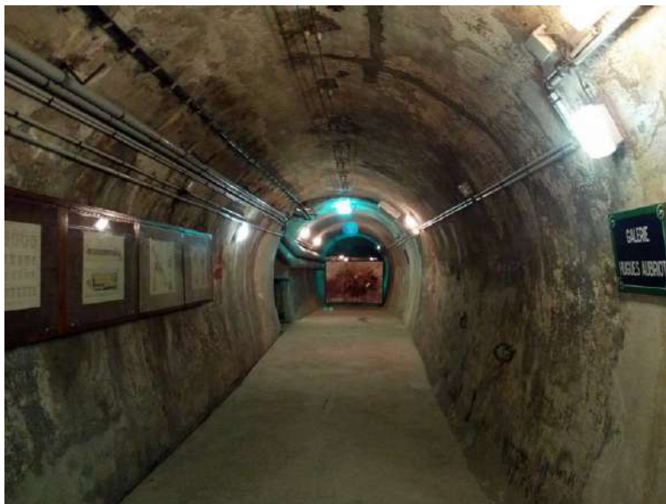
FIGURE 3.3. Photo d'une galerie visitable du réseau d'assainissement parisien qui illustre la taille (hauteur d'Homme) d'une grande partie des canalisations du réseau de Paris. Cette partie du réseau a été transformée en musée des égouts de Paris. Photo : Musée des égouts de Paris.
