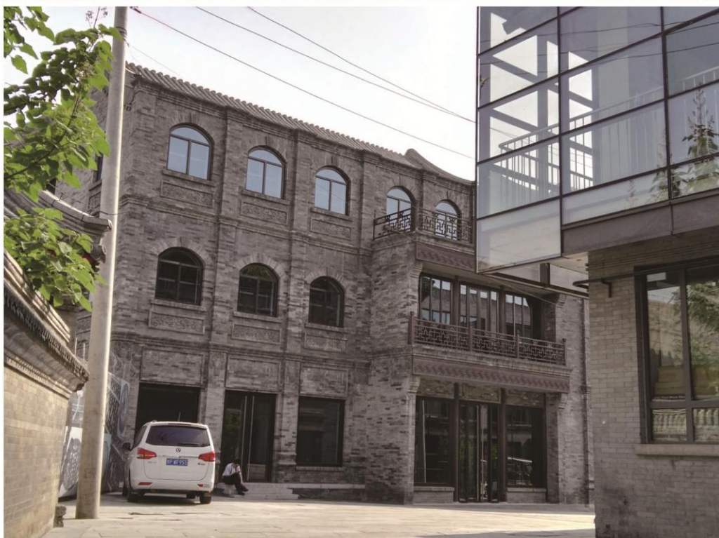
Les locaux commerciaux vides situés sur les parcelles B2 (en haut) et B3 (en bas) à proximité de l'entrée de la rue Qianmen.
