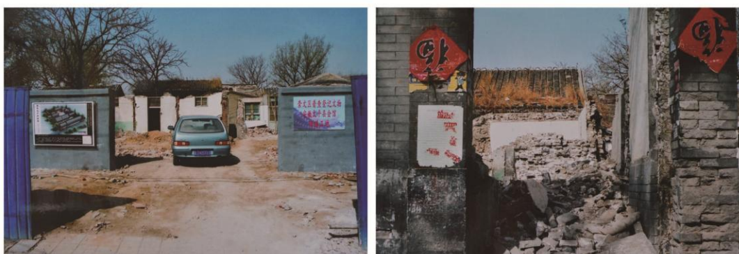
Bâtiment d'association historique Taiping de la province d'Anhui (Cour n° 19 de la ruelle Caochang III).
