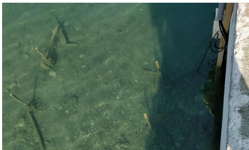
Figure 35. Photographie du dessus de la première plateforme in situ après passage d'un cyclone.
