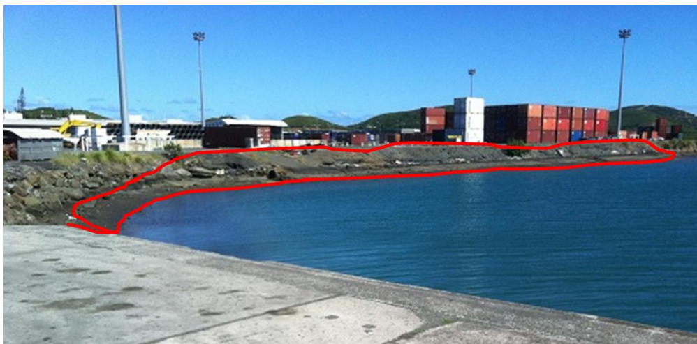
Figure 7. Photo d'une berge du port autonome de Nouméa, formée par remblayage de scories sur la mer (Crédit: Balineau).
