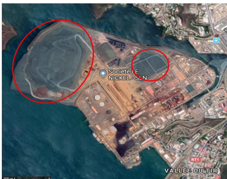
Figure 6. Vue satellitaire de la SLN située à Nouméa avec l'espace occupé par les scories (zone encadré en rouge).
