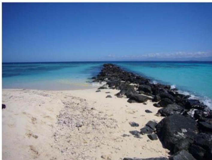
Figure 2. Photographie d'un épis d'enrochement mis en place sur l'îlot Amédée, Nouvelle-Calédonie (Crédit : OBLIC).
