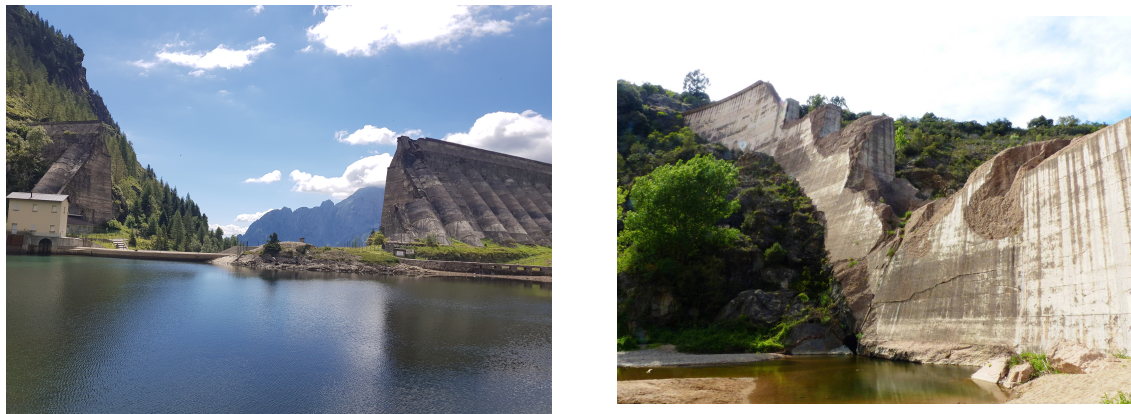
FIGURE 1.2 – Photos des barrages du Gleno ( gauche ) et de Malpasset ( droite ) après les incidents.
