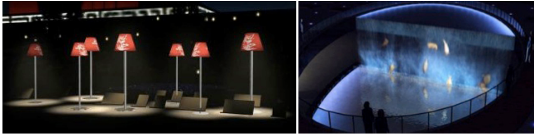
Figure 38. ALFQs sur espaces piétonniers : « éclairage de Salon » et « éclairage commandé »
