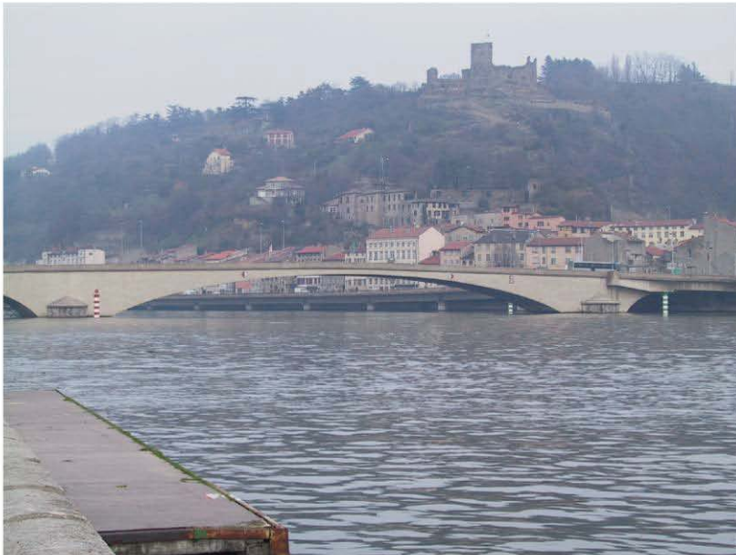
Figure 28. Franchir le Rhône Le pont en béton de Vienne
