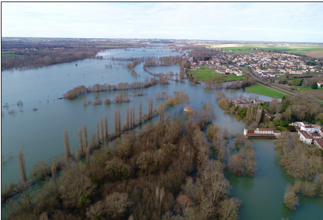
Fig. 18 – Crue du fleuve Charente au niveau de la Baine (Chaniers) le 16 février 2021.
