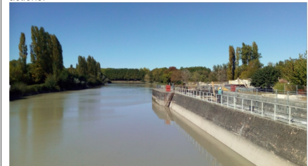
Photo 1 - Chantier en cours d'une passe à poisson sur le fleuve Charente à Saint-Savinien (17) pour assurer la libre circulation des poissons migrateurs au niveau du barrage (04/10/2018).
