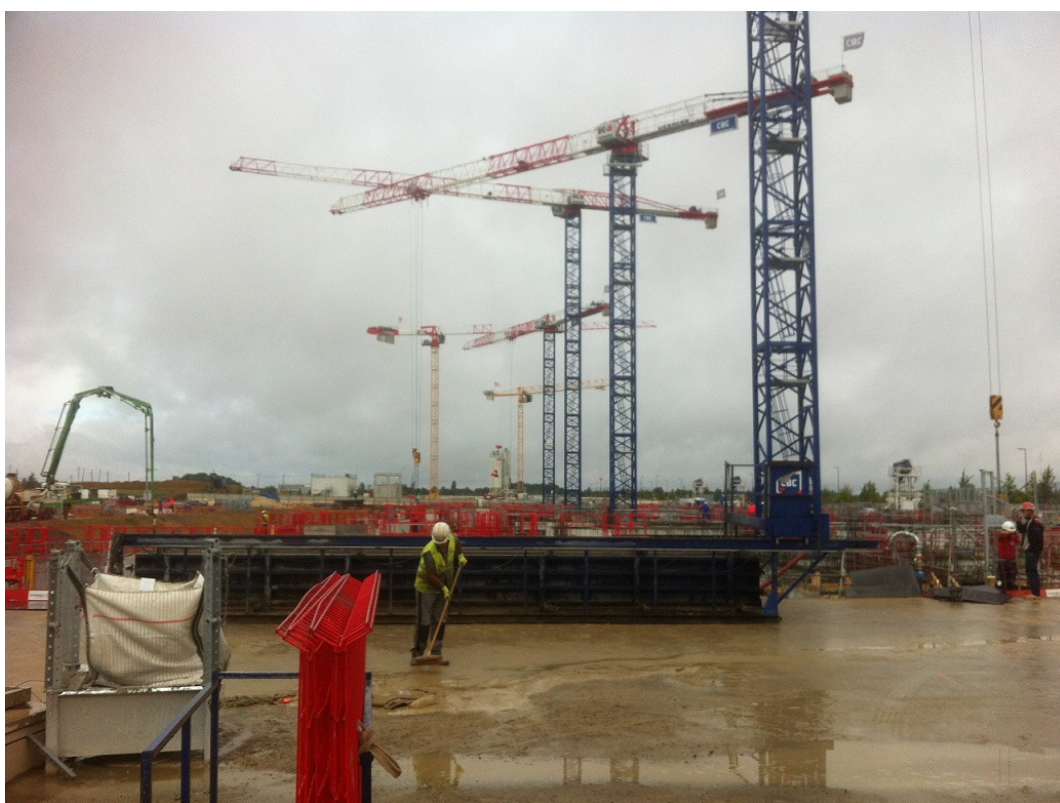
FIGURE 3.1 – Le chantier du Grand Projet d'École , été 2017.
