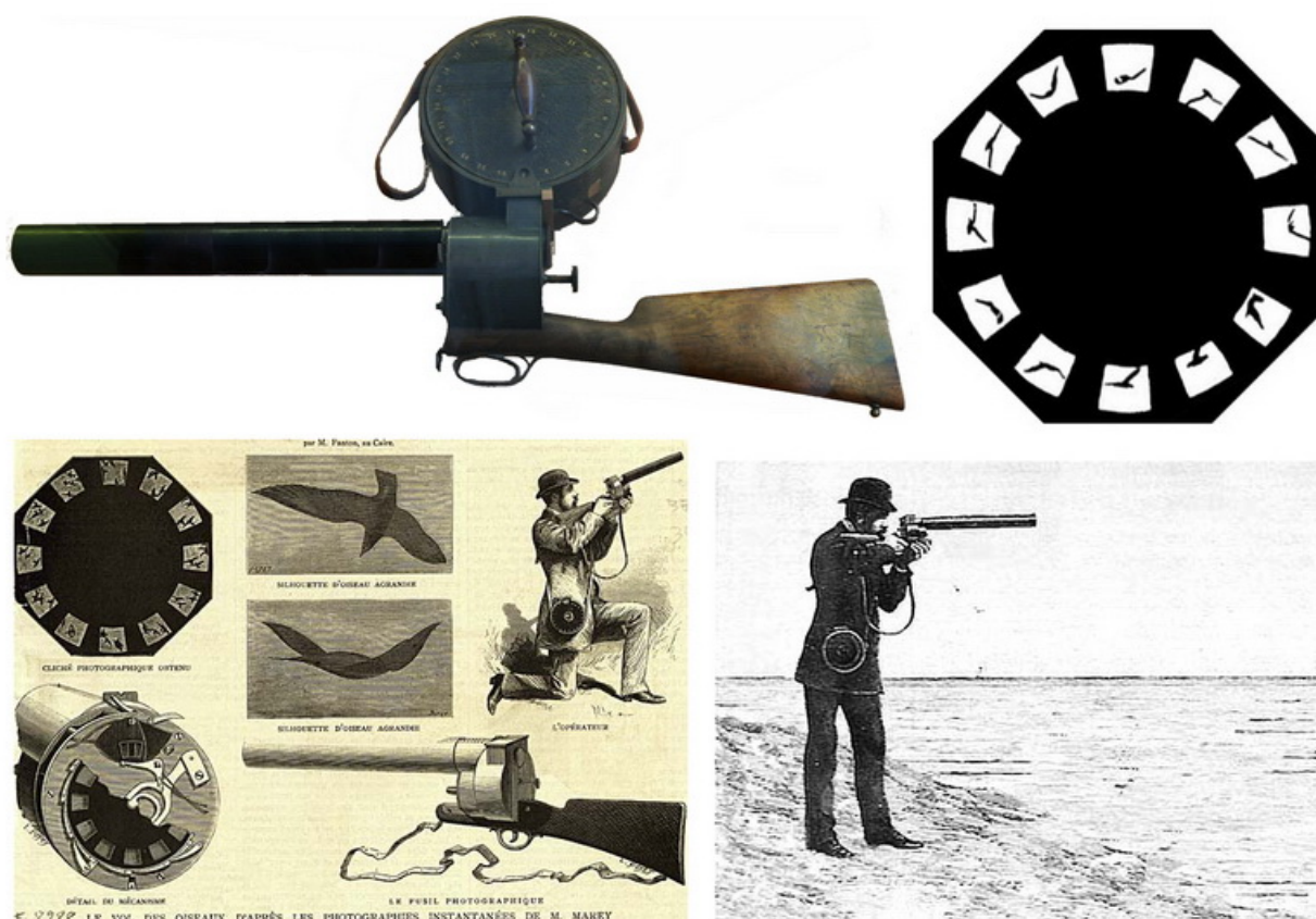
FIGURE 3.5 – Le fusil photographique de Marey utilisé pour décomposer le mouvement du vol d'une mouette (1882).
