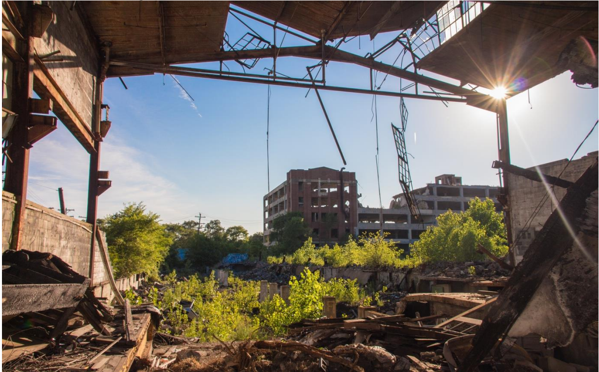
Photographie 4.18. Vue d'une partie de la Packard Plant (Détroit)
