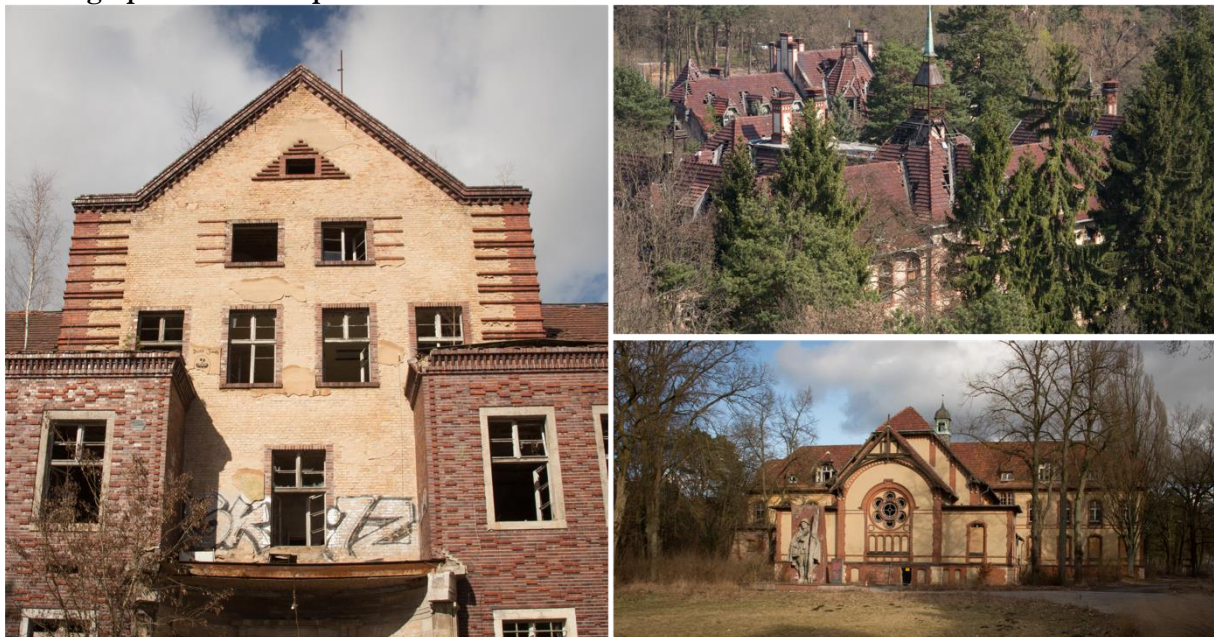
Photographie 4.6. Exemples de bâtiments en ruine de l'ancien sanatorium de Beelitz-Heilstätten
