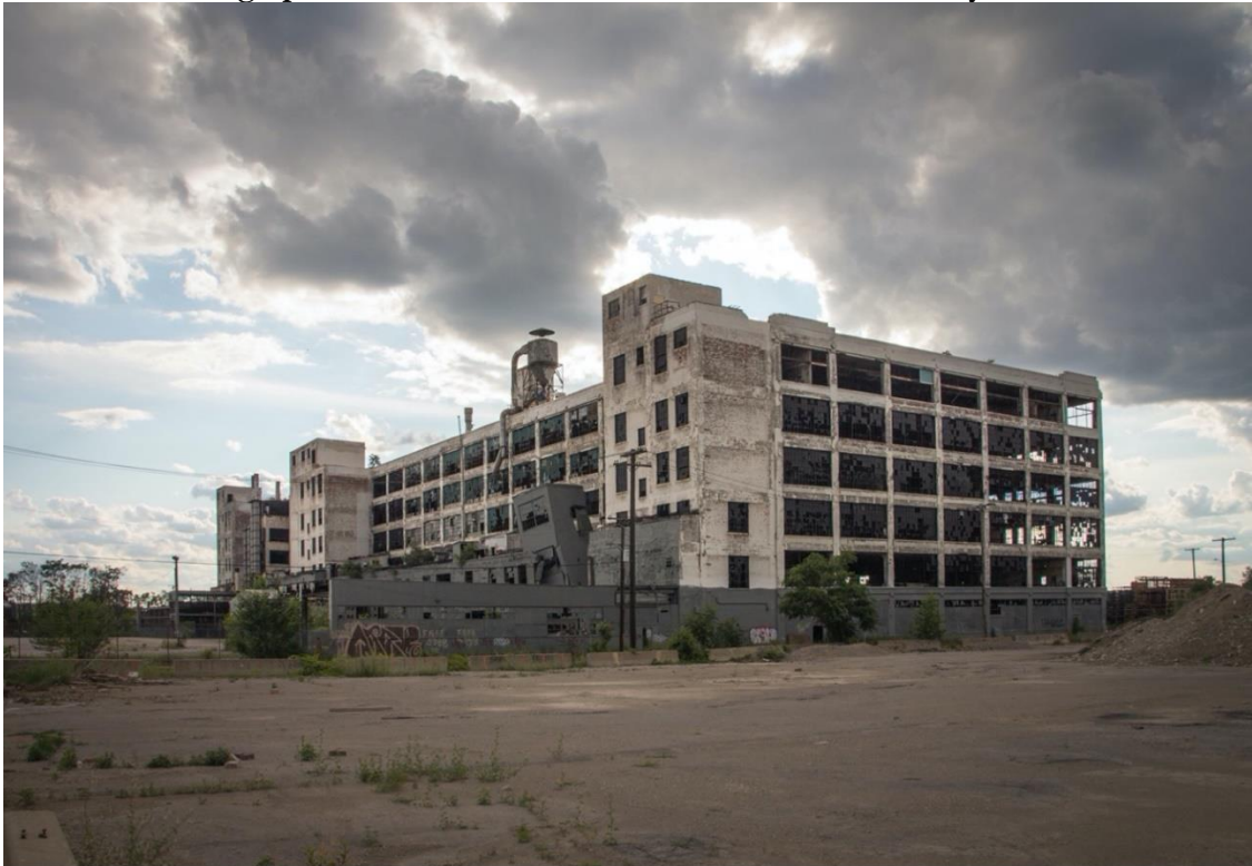
Photographie 2.2. L'ancienne usine automobile Fisher Body Plant 21
