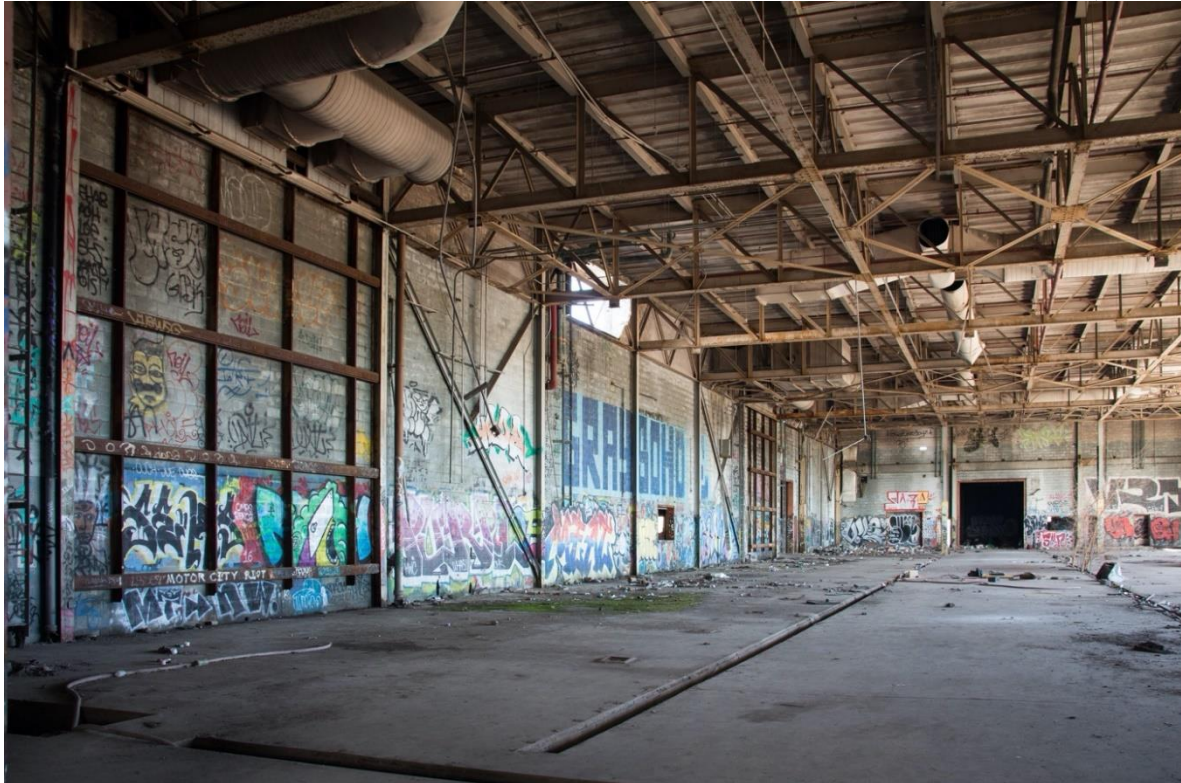
Photographie 4.37. Les vastes espaces intérieurs de l'ancien entrepôt du DWSD)
