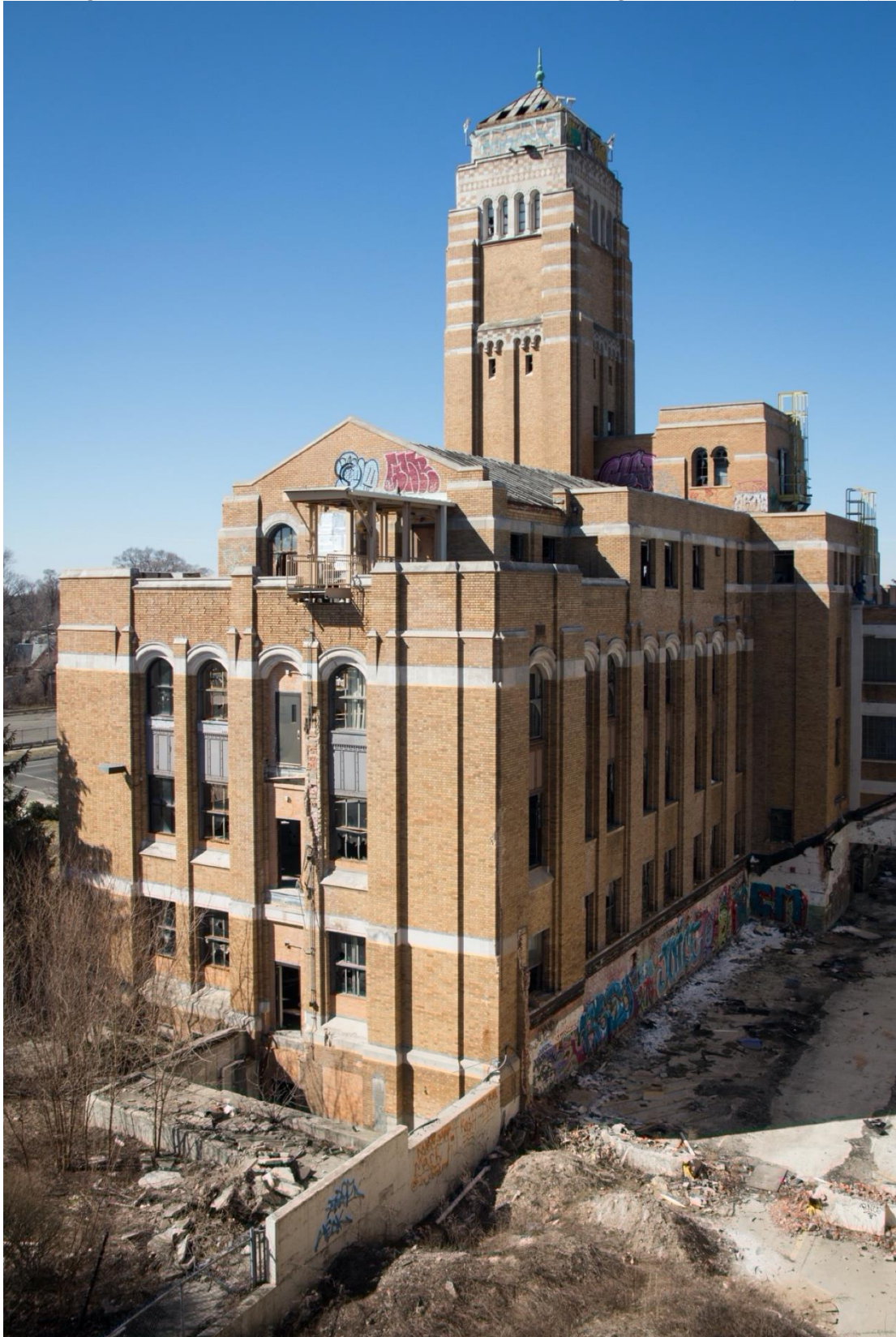
Photographie 4.23. Le complexe de bureaux de l'ancien siège social d'AMC (Détroit)
