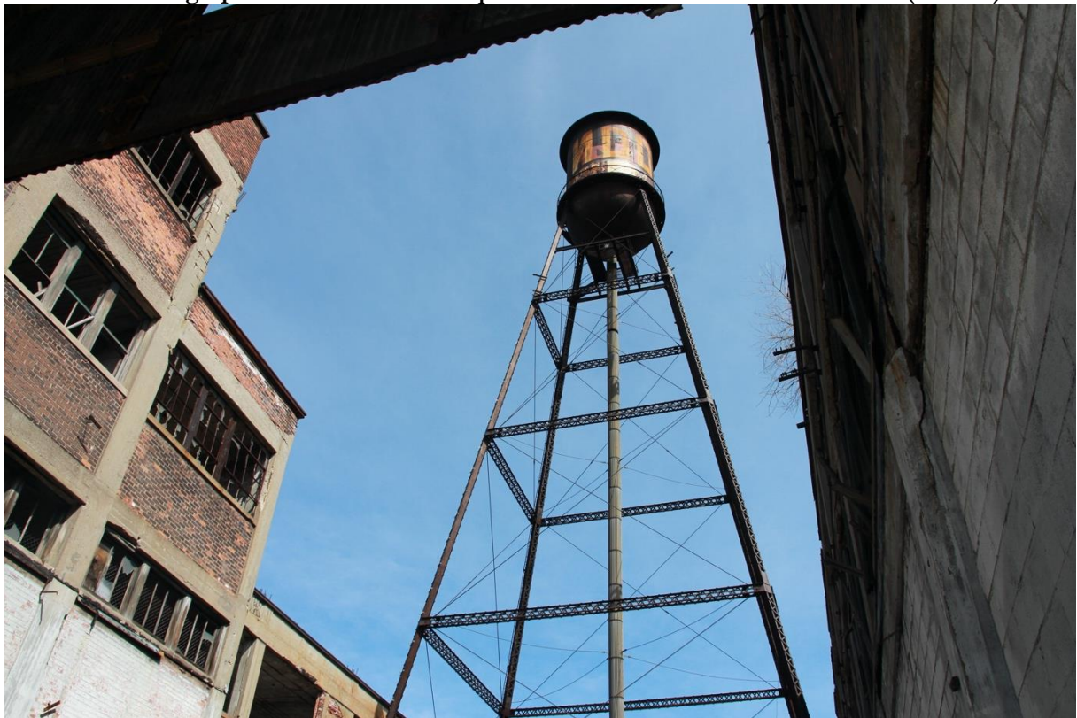
Photographie 4.19. L'emblématique réservoir d'eau de la Packard Plant (Détroit)
