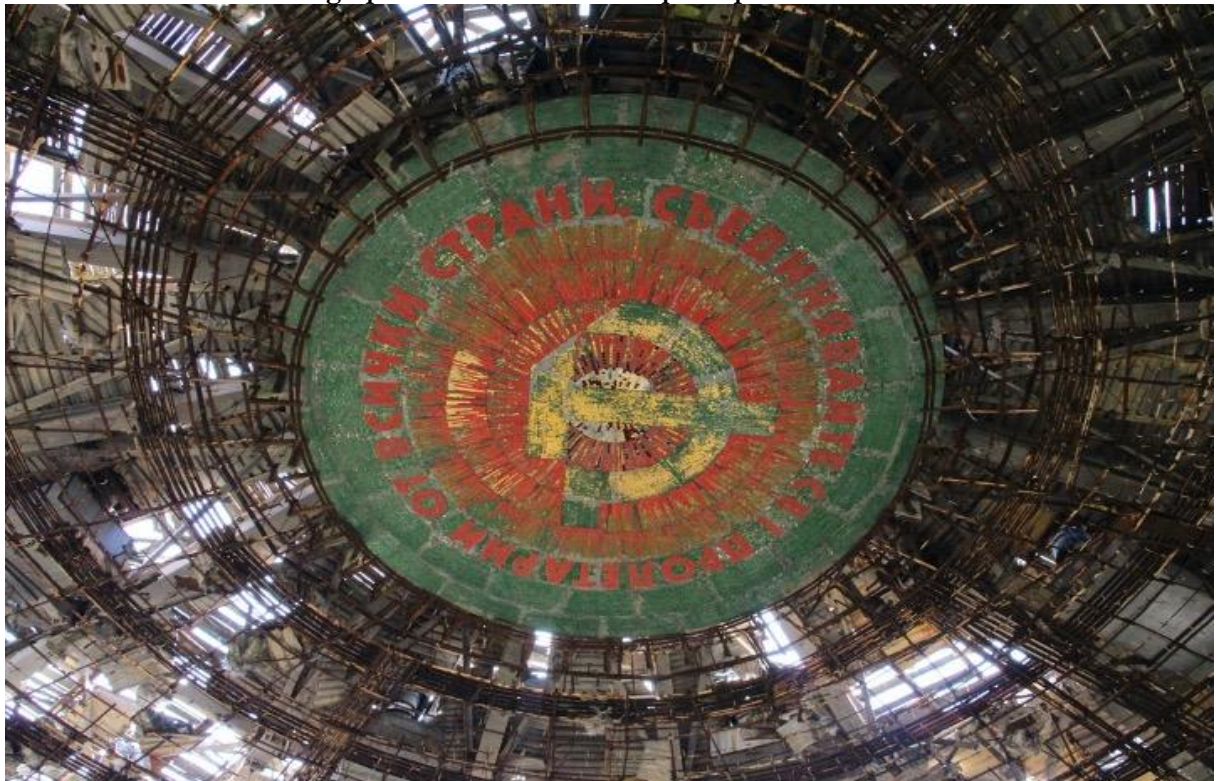
Photographie 1.5. Vue de la salle principale du Buzludzha
