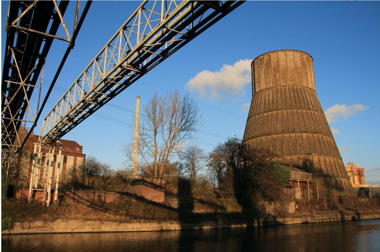
Photographie 1.3. La tour de refroidissement désaffectée de Monceau-sur-Sambre (Belgique)
