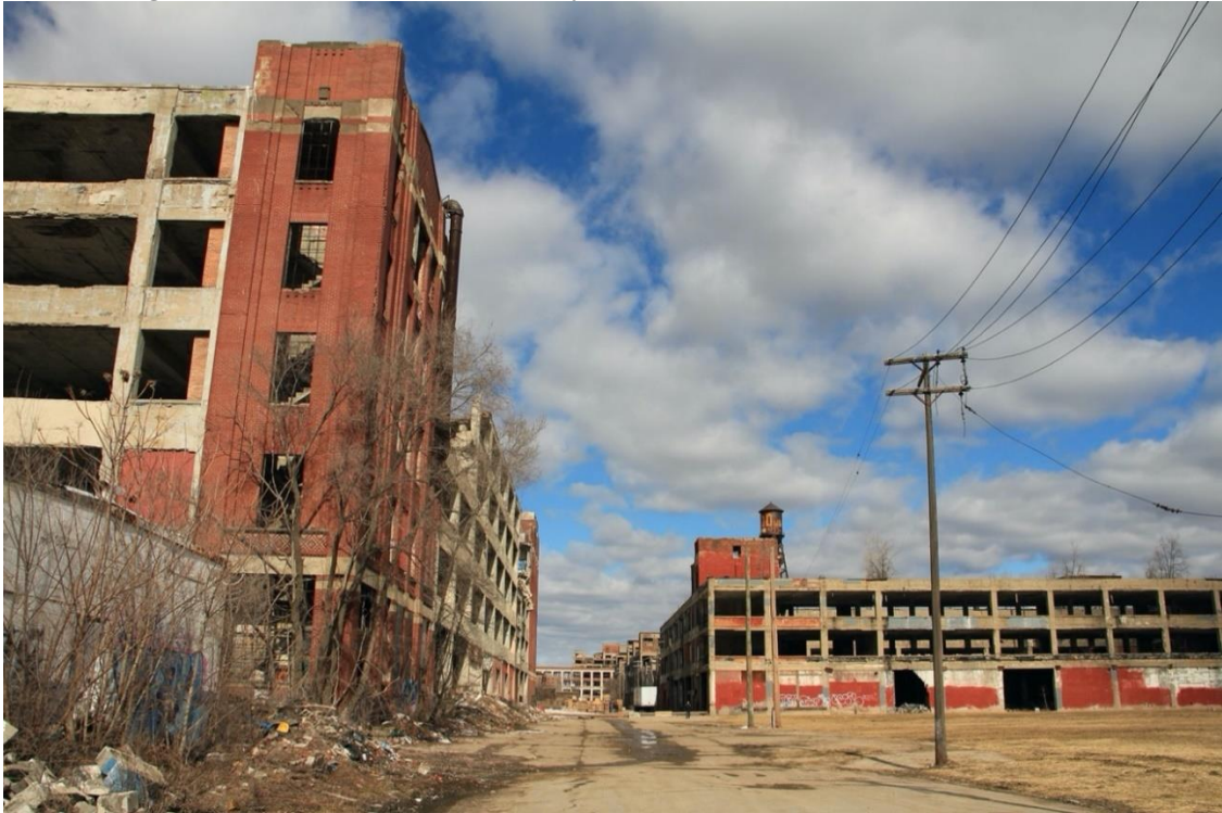
Photographie 2.1. La Packard Plant, symbole de la désindustrialisation de Détroit
