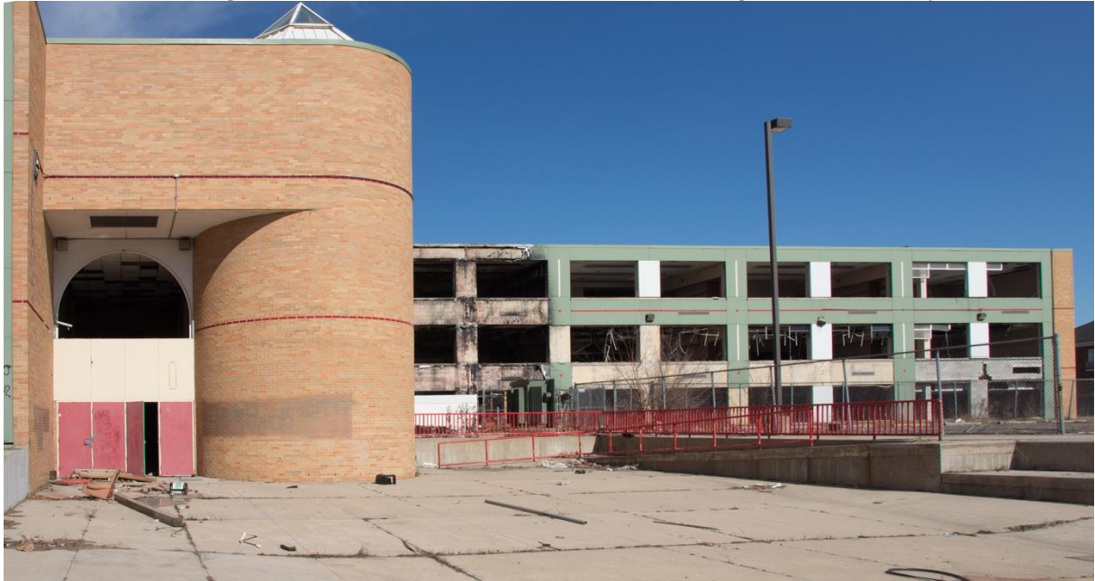
Photographie 4.34. Vue de l'extérieur du Duke Ellington Conservatory
