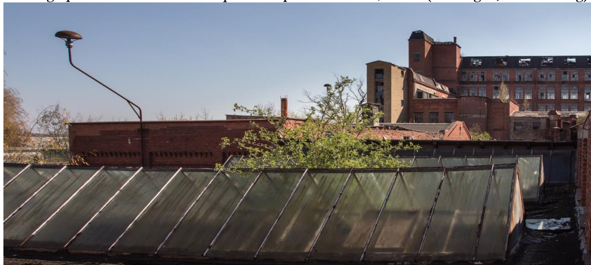
Photographie 1.2. L'ancienne fabrique de draps de Wittstock/Dosse (Allemagne, Brandebourg)
