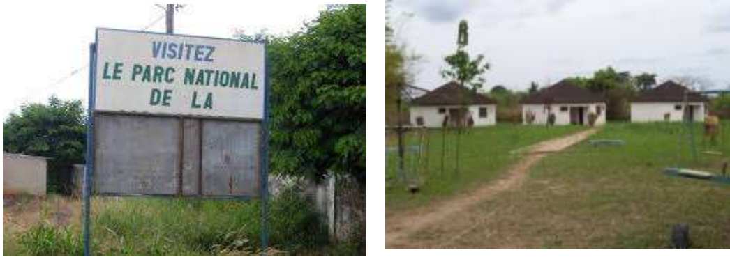
Figure 16 : Aperçu du centre d'accueil du PNM avant et après sa réhabilitation, 2014
