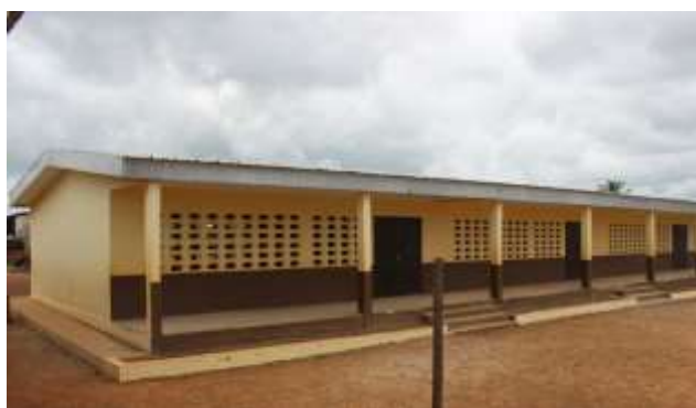
Figure 72: Bâtiment réhabilité par l'OIPR à Kodaya, 2016
