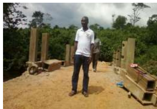
Figure 74: Construction d'un pont sur la rivière San-pedro par l'oipr, 2012
