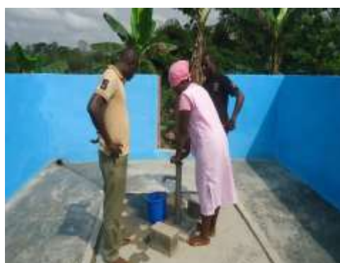
Figure 73: Réhabilitation de la pompe hydraulique par l'OIPR à Djouroutou, 2013
