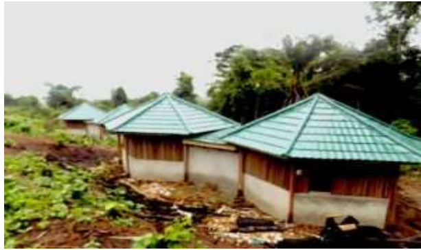
Figure 118: Campement hôtel en construction dans le PNA
