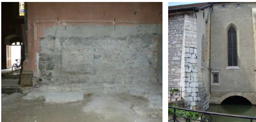
Doc. 54 - Annecy (dominicains) - A gauche : Gouttereau nord du chœur, parement intérieur, fenêtre bouchée de la chapelle du Rosaire et fondations du jubé; A droite : Gouttereau sud du chœur, parement extérieur, fenêtre bouchée de la chapelle de saint Pierre martyr.
