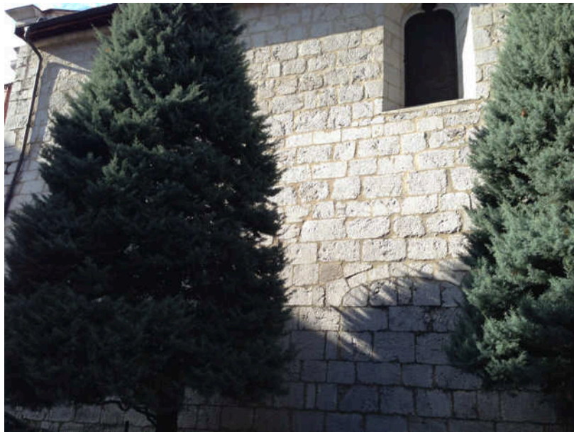
Doc. 98 - Annecy (franciscains) - Aménagement dans le gouttereau oriental de l'église
