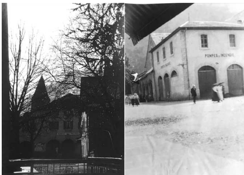
Fig. 162 - Service de secours incendie dans les anciens bâtiments aujourd'hui détruits
