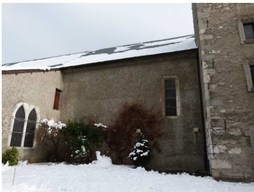
Fig. 137 - Gouttereau occidental de la nef (UM2), corbeaux extérieurs
