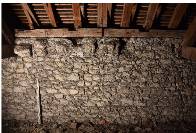
Fig. 153 - UM24, surélévation du gouttereau est du chevet
