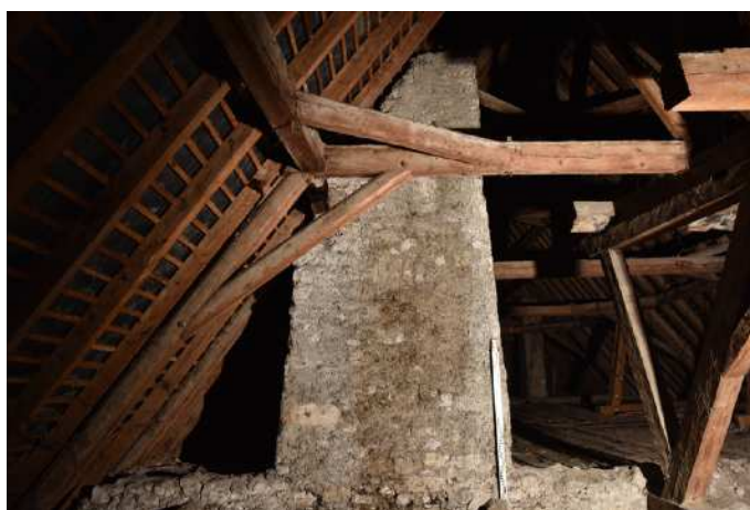
Fig. 154 - Conduit de la cheminée (sacristie) dans UM10 et UM26
