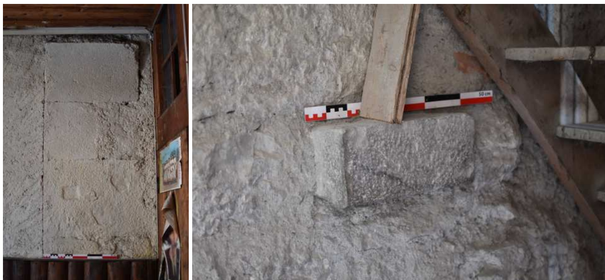
Fig. 149 - Clocher. Départ d'arc dans le prolongement de l'UM7. Corbeau sur l'UM10.
