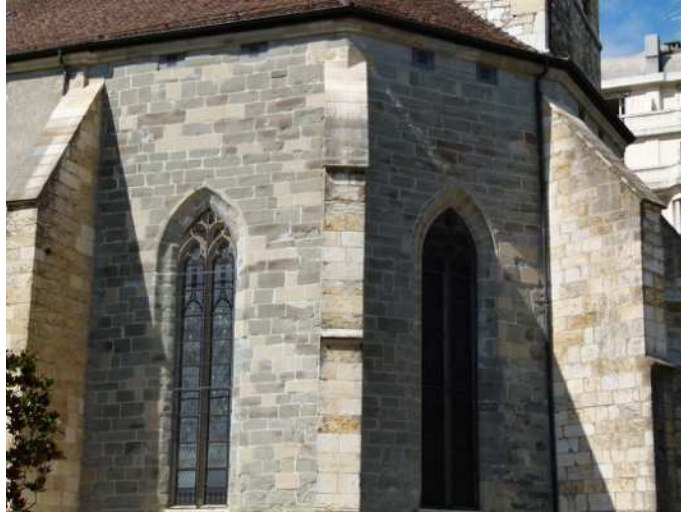
Fig. 127 -Utilisation de la molasse dans les élévations du chevet
