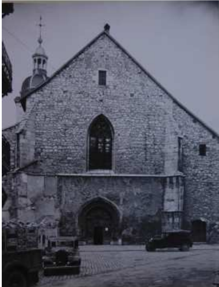
Fig. 45 - Façade occidentale : vers 1937, lors de la démolition de la maison adossée à l'angle gauche de la façade (A.M.A., 2 M1 3bis)
