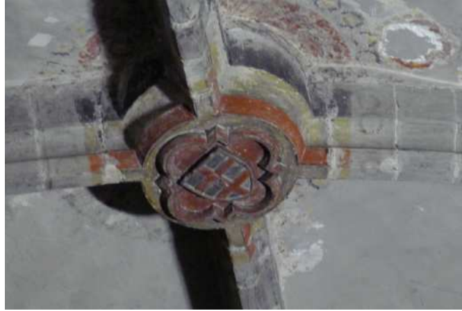
Fig. 121 -Clé de voûte annulaire au rez-de-chaussée du clocher
