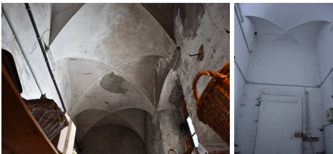
Fig. 145 - Poursuite du couloir de distribution voûté (petit local technique municipale à droite)
