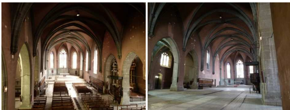
Fig. 113 - Vues générales de la nef avant les travaux de 2015 (vers l'est)
