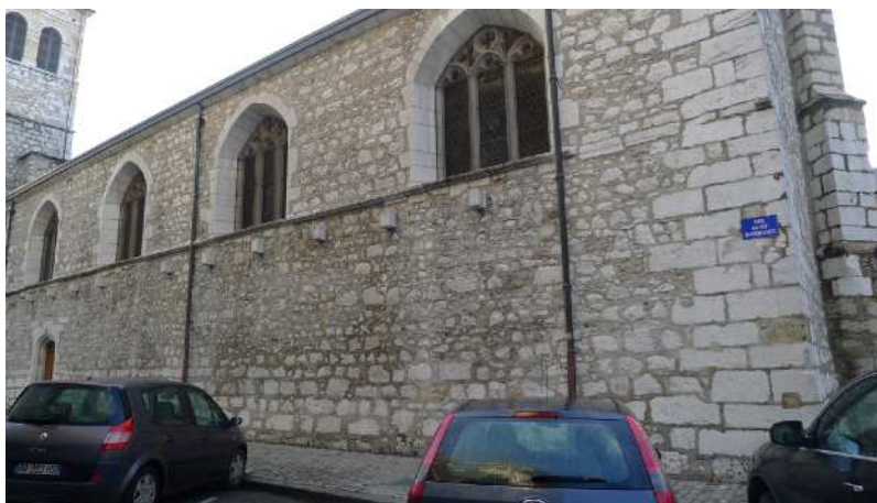
Fig. 117 -Bas-côté nord (extérieur)
