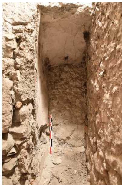
Fig. 151 - Petite baie (UM10) donnant originellement sur le sanctuaire
