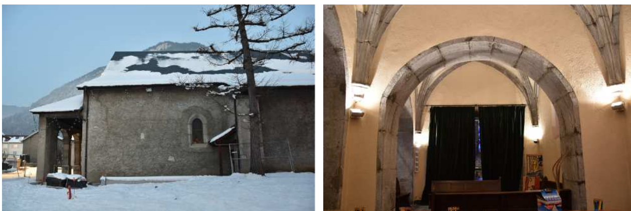
Fig. 143 - Chapelle nord (extérieur et intérieur)
