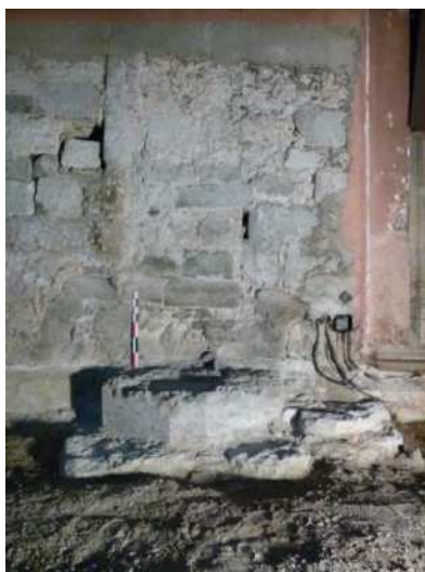
Fig. 130 - Fondation et base d'une pile mises au jour à l'aplomb d'un cul-de-lampe (gouttereau sud du chœur)
