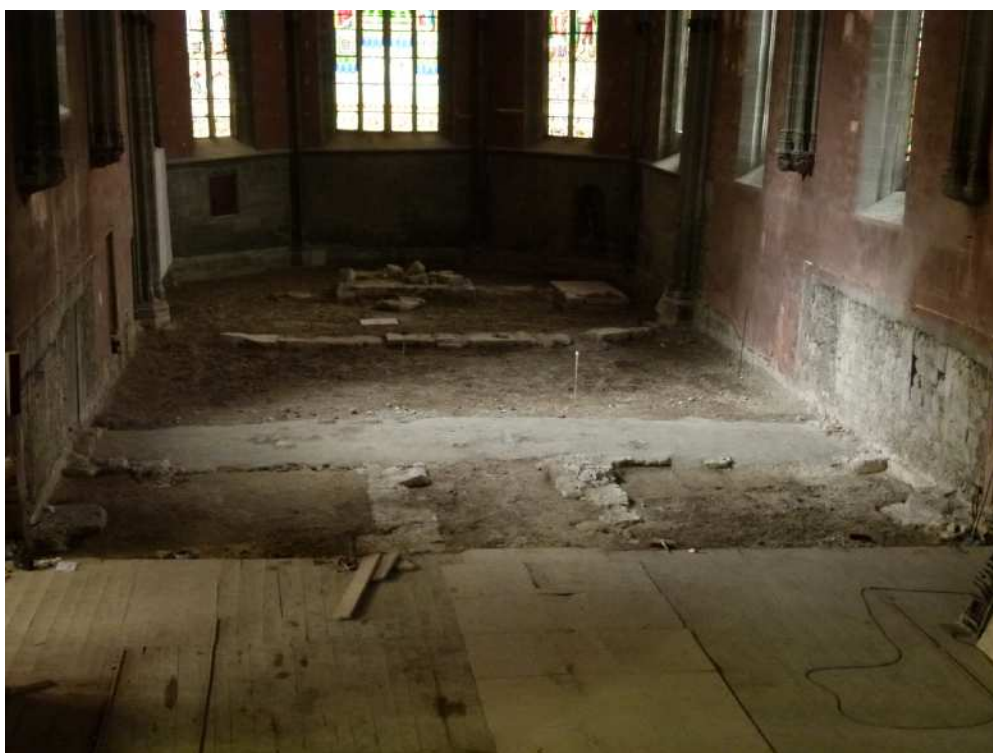
Fig. 125- Fondations du jubé (et des aménagements liturgiques du XIXe siècle)
