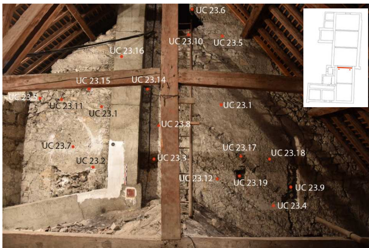
Fig. 152 - UM23, surélévation du gouttereau nord du chevet (détail des UC)
