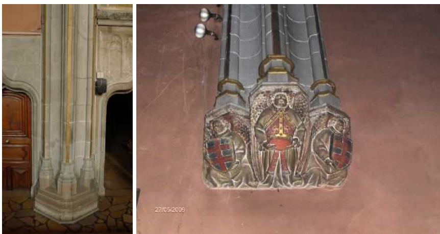
Fig. 111 - Retombées des ogives du sanctuaire (à gauche) et du chœur (à droite)
