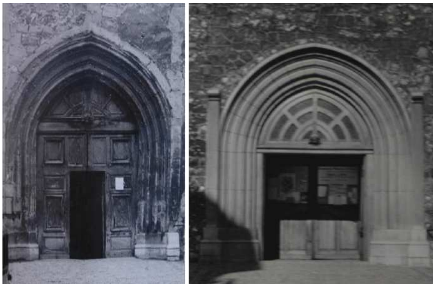
Fig. 46 - Façade occidentale avant et après travaux, 1937 (A.M.A., 2 M1 3bis).
