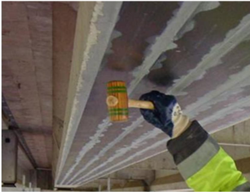
FIGURE 1.5 – Technique d’inspection de renforts composite sur du béton : sondage au maillet [32]
