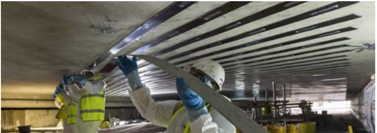
FIGURE 1 – Renforcement d'ouvrage par collage de matériaux composites [1]
