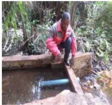
**Figure 20 B:** Captage d'une source d'eau potable a' Baho dans Baham
