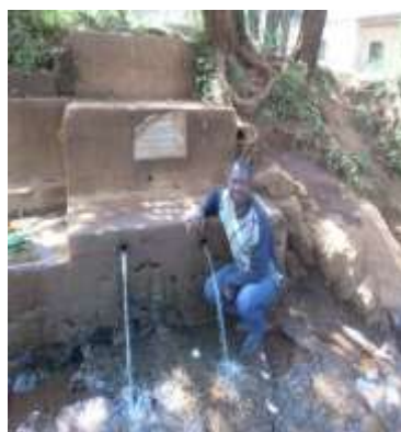
Figure 20 A: Réalisation d'un point d'eau potable a' Babadjou
