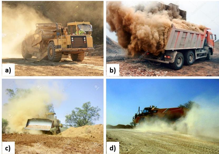
**Figure 1-2 : Émissions de poussières lors a) du décapage du sol, b) du chargement des camions, c) des activités de bulldozer et d) de la circulation des engins (crédits : Getty Images et Walker, 2012)**
