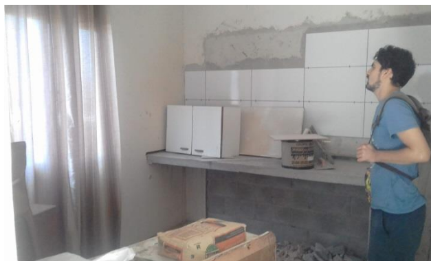
Figura 22: Martin durante a reforma da sua casa (foto do autor).
