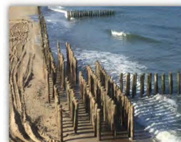
FIGURE 3 – Pieux hydrauliques pour la protection des côtes (plage Atlantique, source : la-voixdunord.fr ).
