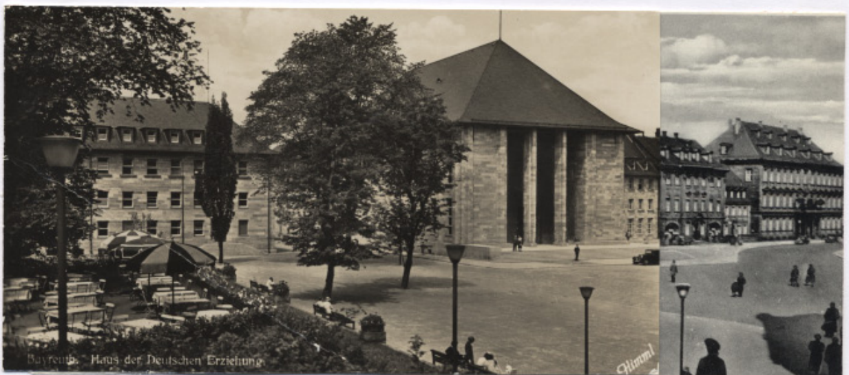
264 Montages de deux vues prises en 1936 : à gauche la maison de la Sténographie, puis la maison de l'Education allemande, le bâtiment abritant la bibliothèque enfin la maison Layritz et l'hôtel de ville.
