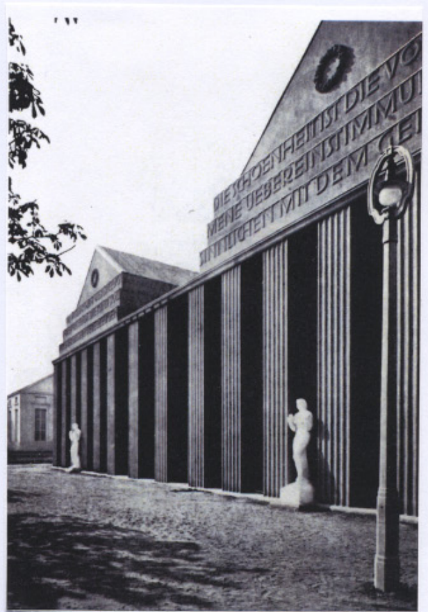
438 Maison de l'Autriche, exposition du Werkbund, Cologne, 1914, façade principale, inscriptions de Rudolf von Larisch, architecte Josef Hoffmann.
