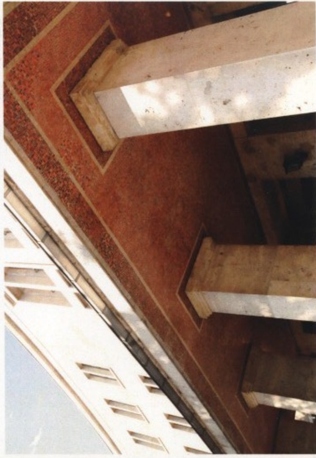
379 Détail d'une sous-face, porche d'accès aux bâtiments administratifs, place Ronde, Tempelhof, 2006.
