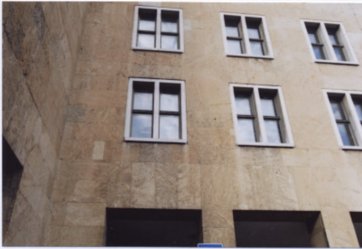
419 Aéroport de Tempelhof, détail d'un linteau galerie longeant la cour d'honneur, 2010.
