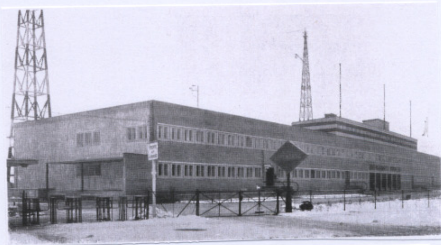
195 Le terminal de Tempelhof partiellement construit, façade côté ville, 1929.
