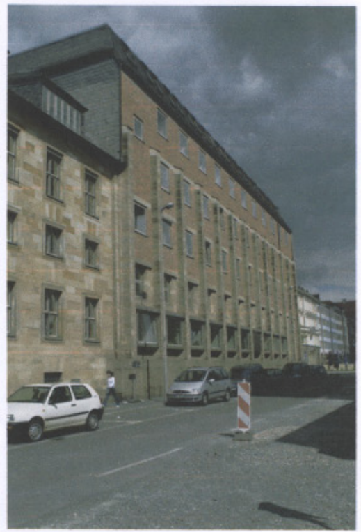
300 Quatrième étage ajouté, piliers non prolongés.
