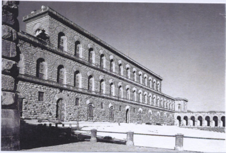
119 Florence, palais Pitti, façade principale.
