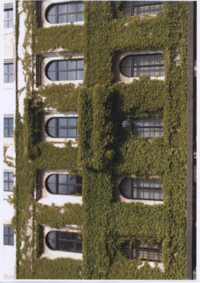
407 12, Arcisstrasse, Munich, détail de la façade, 2006.
