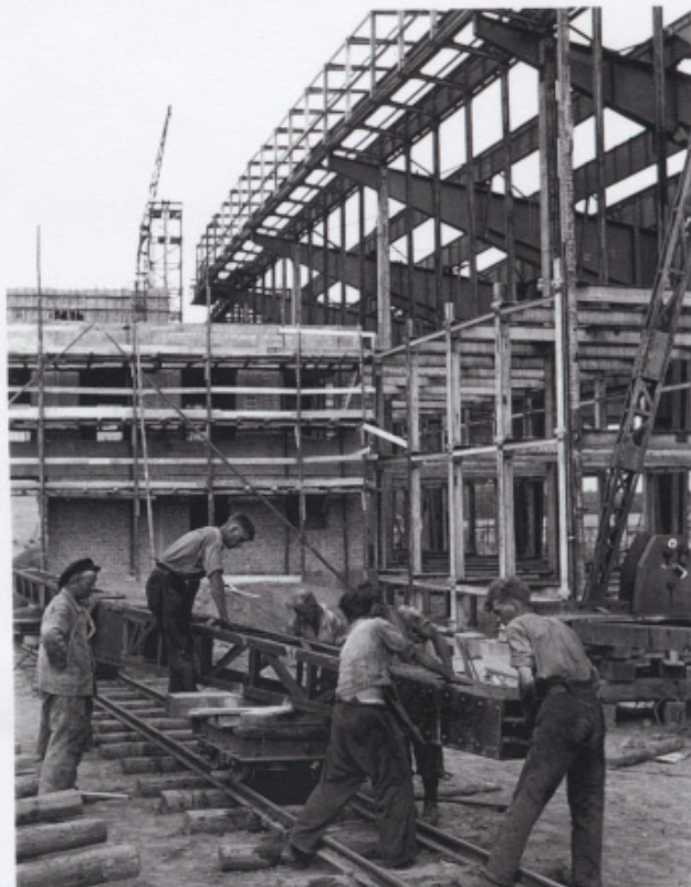
242 Photo de chantier du hall d'embarquement. L'arrière des poutres en cantilever est visible avec leur tirant venant s'ancrer dans le sol.
