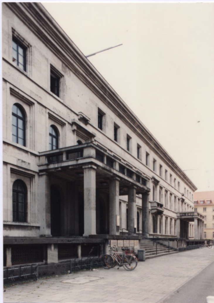
81 Façade du bâtiment administratif : les deux porches et le muret de délimitation du terrain le long de l'Arcisstrasse, 1995.
