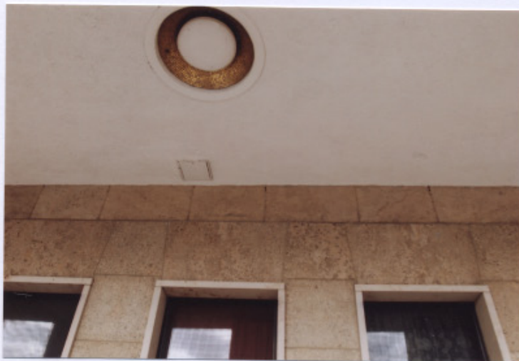
421 Aéroport de Tempelhof, détail des linteaux au-dessus des baies, le long d'un passage traversant, Tempelhofer Damm, 2010.
