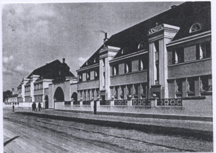
441 Kurz, Herbert : bâtiment d'accès, BNW, 1924.
