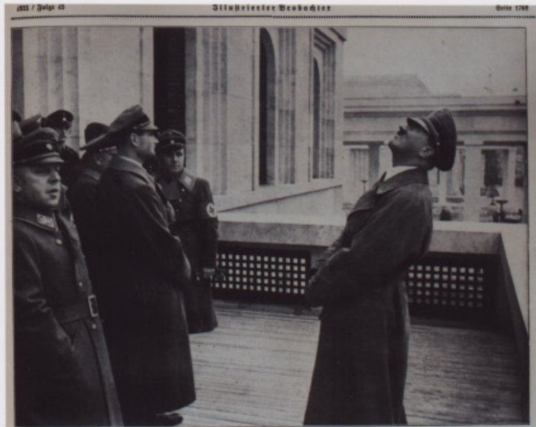
37 Visite de fin de chantier : Hitler sur le "balcon du Führer" au 1er étage du bâtiment du Führer, Munich.
