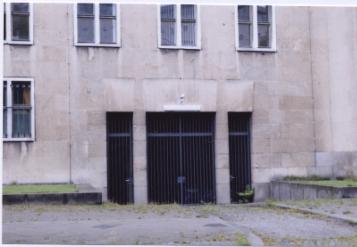
420 Aéroport de Tempelhof, porte secondaire le long de Tempelhofer Damm, 2010.
