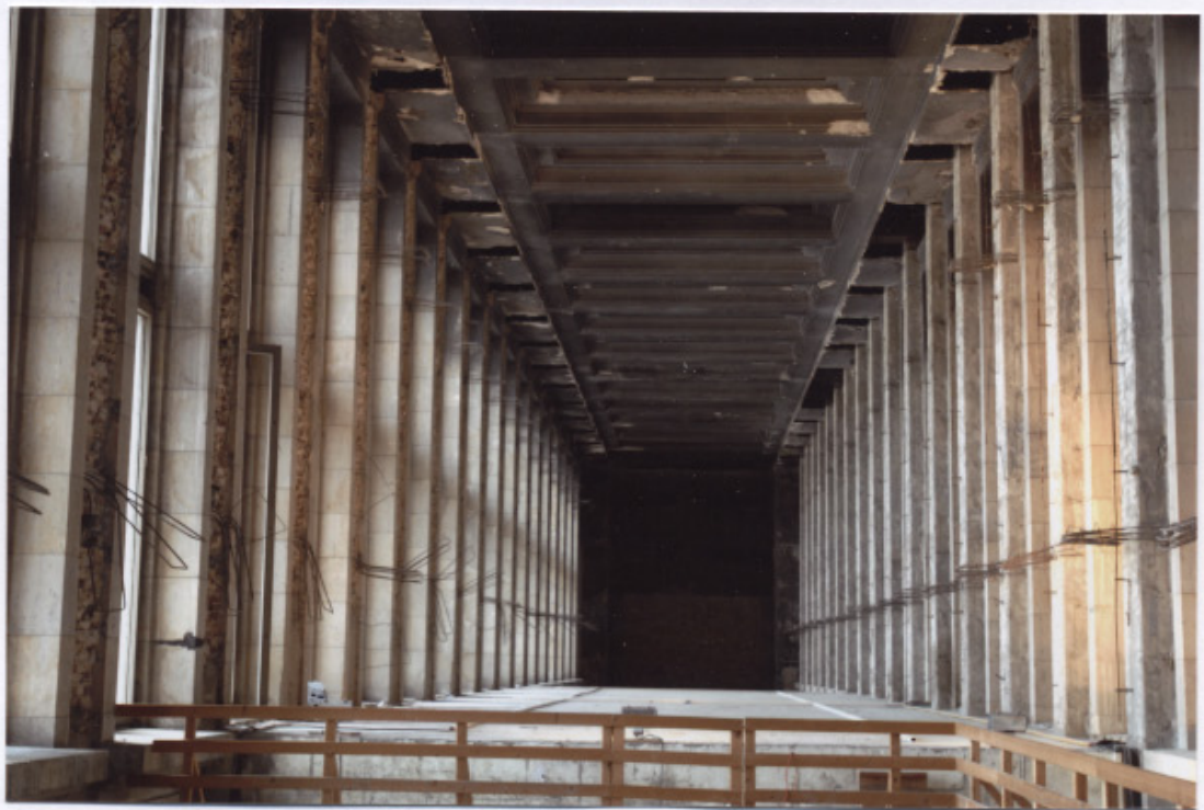
251 Partie supérieure du hall d'accueil, avec ses piliers en BA dans l'attente de leur habillage, et son plafond en stuc à caisson, dans son état de la fin de la guerre . 2005.
