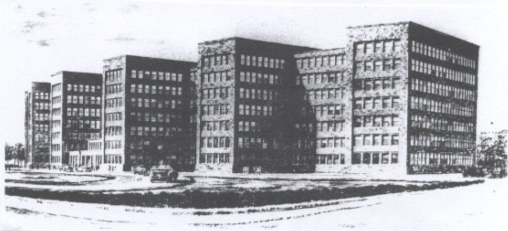
141 Les façades du bâtiment administratif de I.G. Farben.
