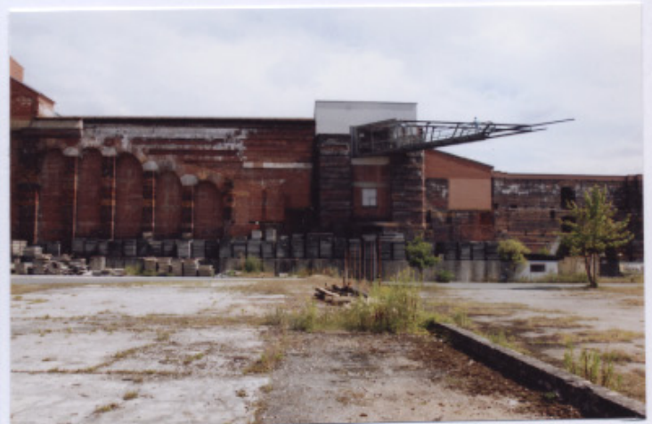
356 La "flèche", quand la structure de métal s'achève et domine la vaste cour du hall des Congrès, 2012.
