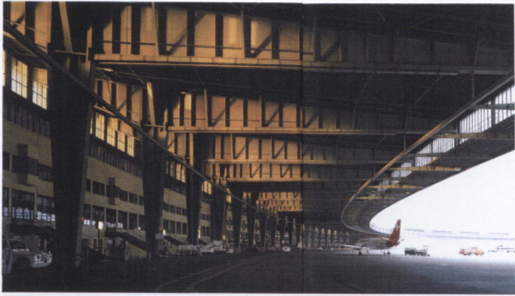
222 L'exceptionnelle volumétrie générée par les poutres en cantilever des portiques et par la courbe de l'aire d'embarquement.
