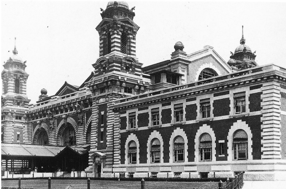
Ill. 28 : Le nouveau bâtiment du centre d'immigration d'Ellis Island, avril 1900.
