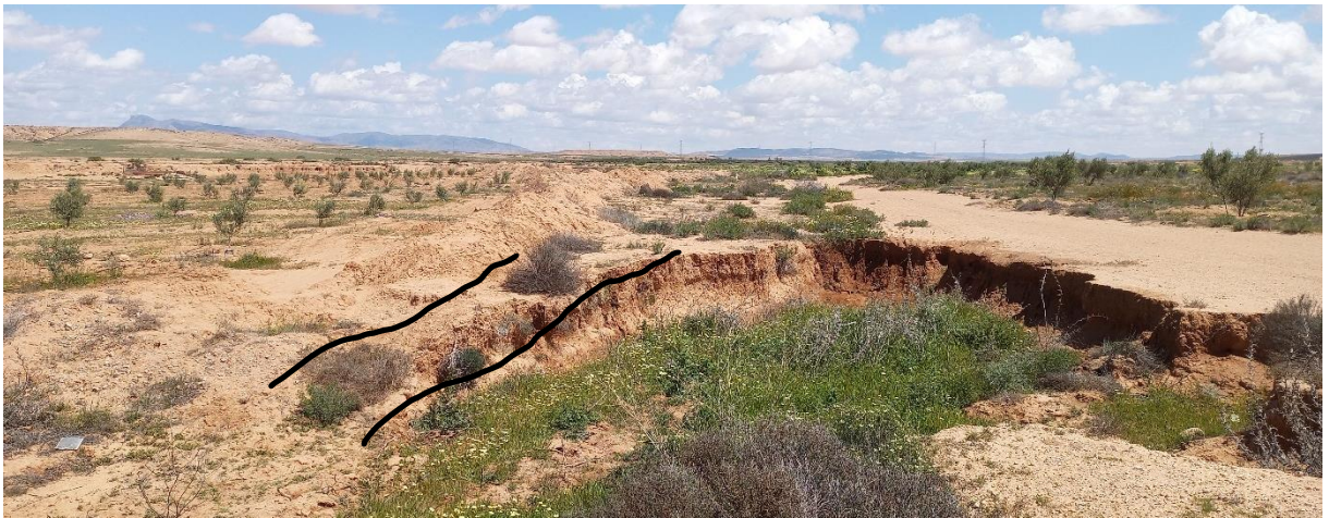
الصورة رقم 67: تدخل بوضع حواجز ترابية لمنع التعرية التراجعية بسهب الفيضة.
