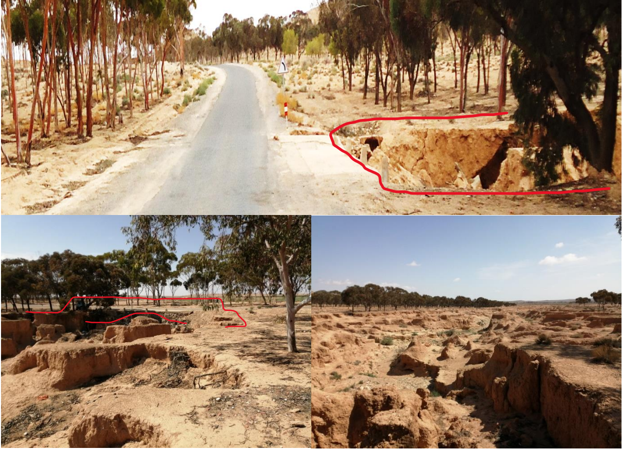
الصورة رقم 11: طريق مهددة بسبب التعرية التراجعية، الطريق الرابطة بين حامة قطيطر والطريق الوطنية 6.
