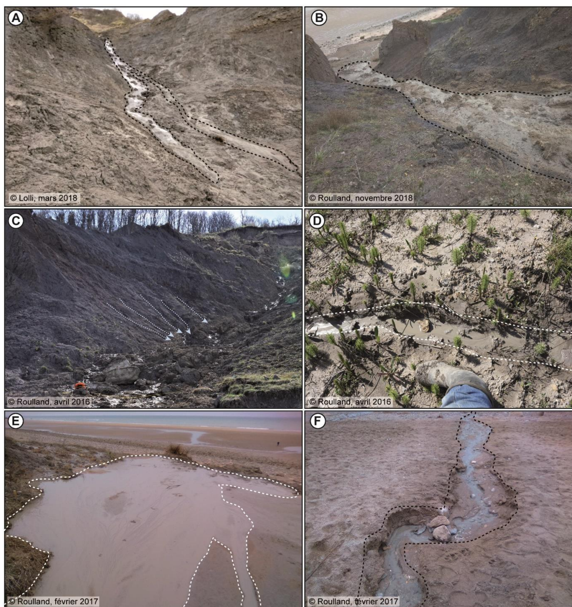
Figure 2.22 : Illustration des différentes formes de ruissellement observables dans les badlands des Vaches Noires ; A) Ruissellement turbide digité dans une ravine (photo : Lolli, mars 2018) ; B) Ruissellement turbide concentré dans une ravine ; C) Ravinement latéral des flancs de crête ; D) Ruissellement turbide concentré dans la zone d'épandage ; E) Zone humide formée par dispersion des écoulements concentrés dans la zone d'épandage ; F) Ruissellement turbide ayant atteint le haut de plage
