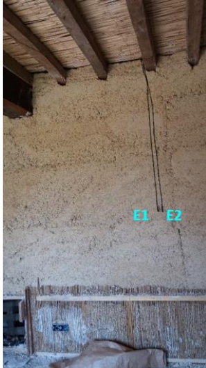
Figure IV-9 : Implantation des capteurs l'interface béton de chanvre-enduit intérieur et en surface intérieure (en attente) en paroi nord
