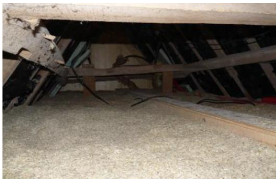
Figure I-41 : Isolation en anas de lin et implantation des capteurs (Brachelet et al. 2020)
