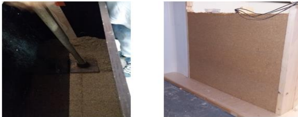
Figure II-10 : Mise en œuvre de la paroi terre-chanvre (gauche) et paroi démontée avant enduit (droite)
