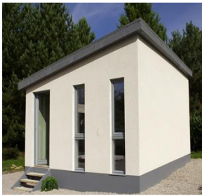
Figure I-33 : Bâtiment test "Hempod" – Université de Bath
