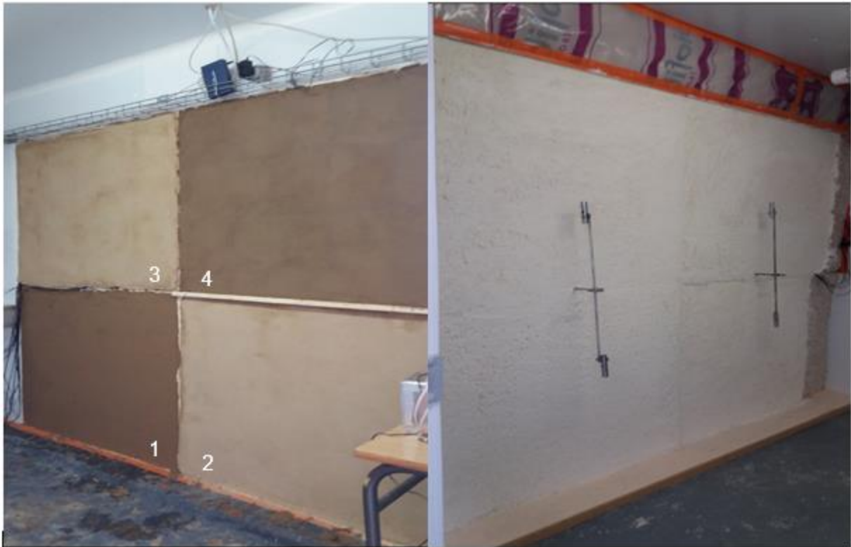
Figure II-8 : Vues intérieure (gauche) et extérieure (droite) des 4 parois testées après les applications des enduits intérieurs et extérieurs 1- Paroi Terre chanvre, 2 – Paroi ISOBIO, 3 – Paroi PVA-Chanvre avec parement en résidus de rafles de maïs, 4 – Paroi en résidus de paille de Colza
