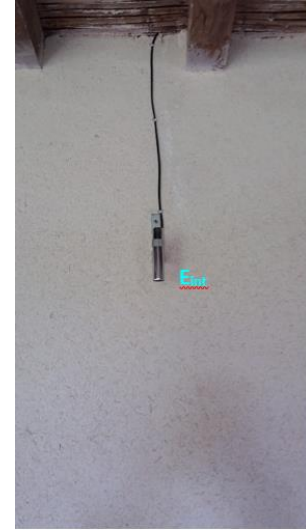
Figure IV-11 : Implantation du capteur en ambiance intérieure en paroi nord
