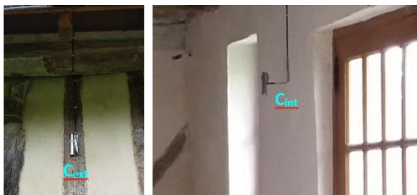
Figure IV-7 : Implantation des capteurs en ambiances extérieure et intérieure en paroi sud
