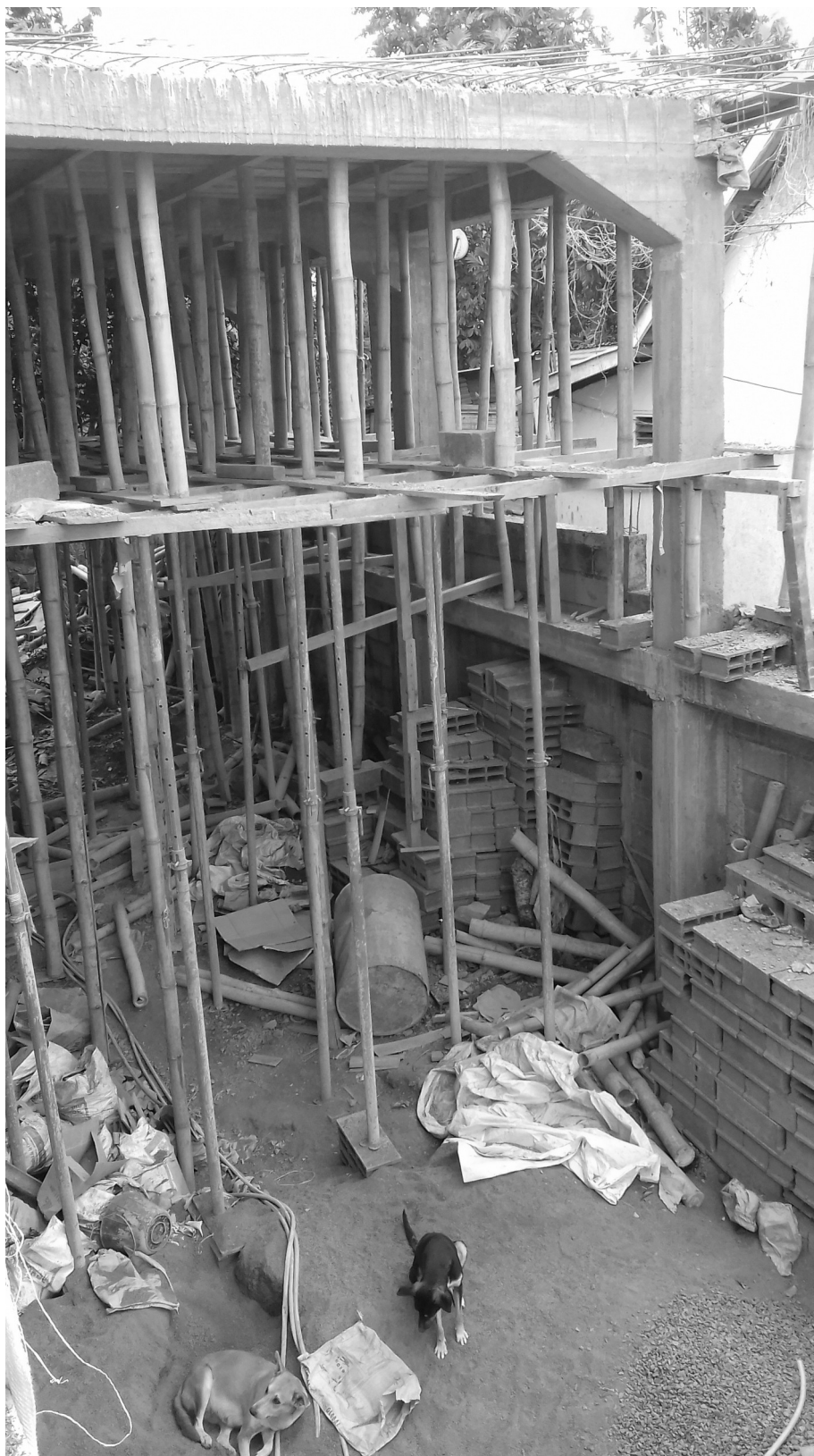
Le chafø de la première partie de la dalle que nous devons démonter : la partie inférieure de l'échafaudage est constituée d'étais métalliques et d'étais de bambou, l'étage intermédiaire supporte une nouvelle série d'étais de bambou, plus courts, qui soutiennent les plaques de bois inférieures du coffrage de la dalle.
