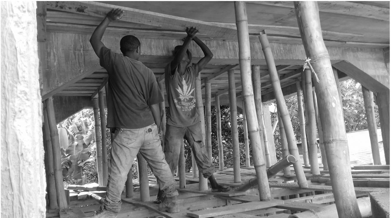
*Fundi et Tavandaï retirent un chevron sous l'une des planches de coffrage. Le chevron dans le quart supérieur droit de l'image repose en équilibre sur un unique étais central, permettant de maintenir les planches de coffrage.*
