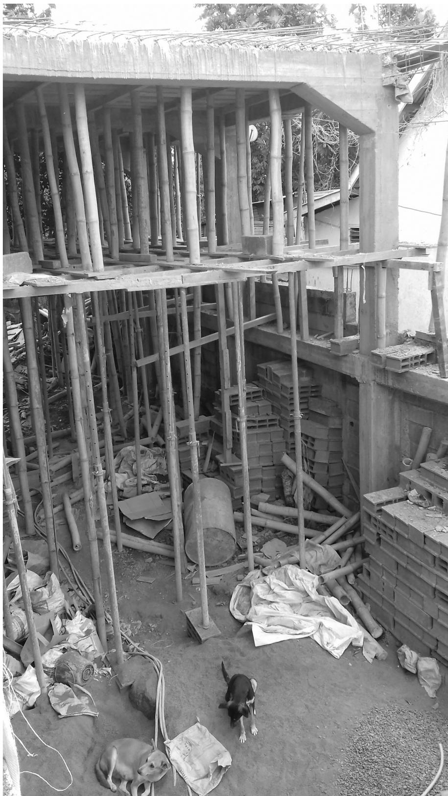
*Le chafø de la première partie de la dalle que nous devons démonter : la partie inférieure de l'échafaudage est constituée d'étais métalliques et d'étais de bambou, l'étage intermédiaire supporte une nouvelle série d'étais de bambou, plus courts, qui soutiennent les plaques de bois inférieures du coffrage de la dalle.*
