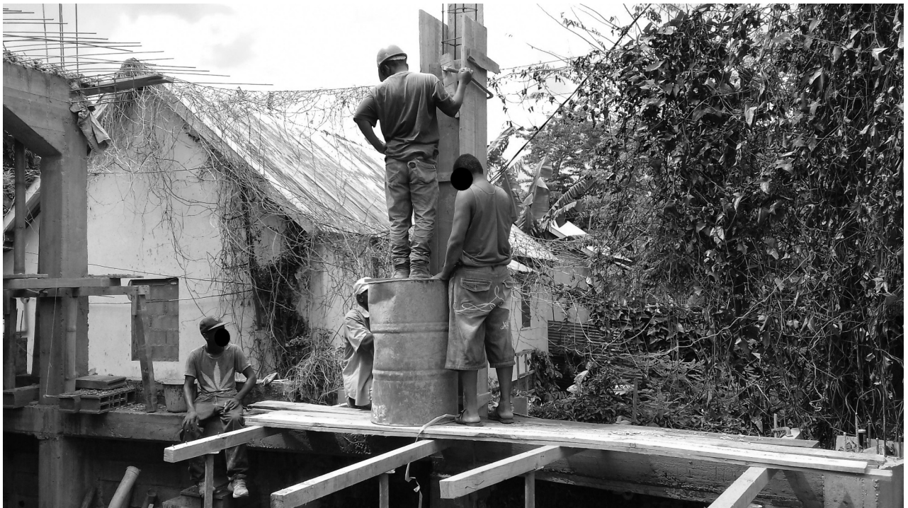
En équilibre sur un bidon, Fundi ajuste les planches de coffrage sous le regard de Tavandaï.
