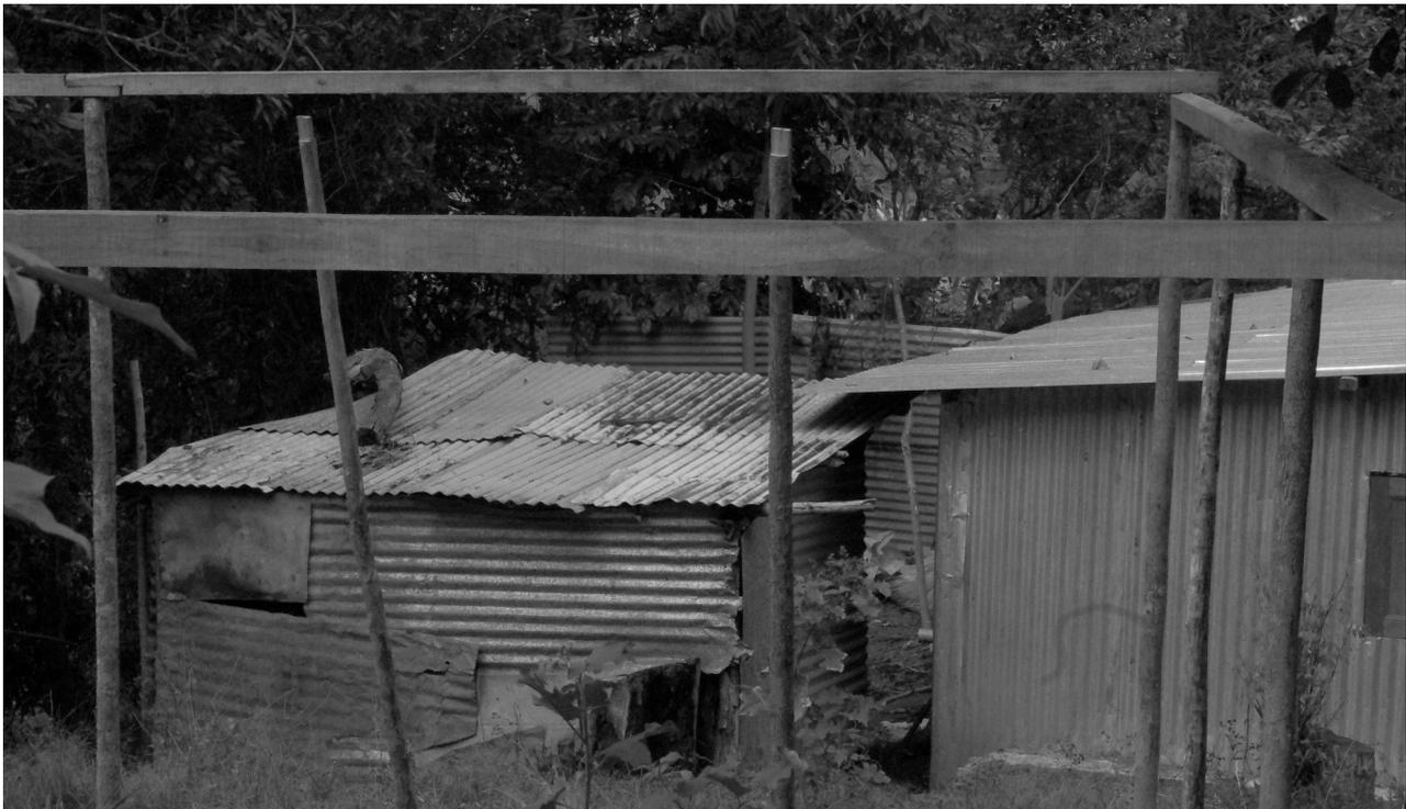
*Étape intermédiaire de la construction : pose des poutres horizontales sur les étais en bois.*
