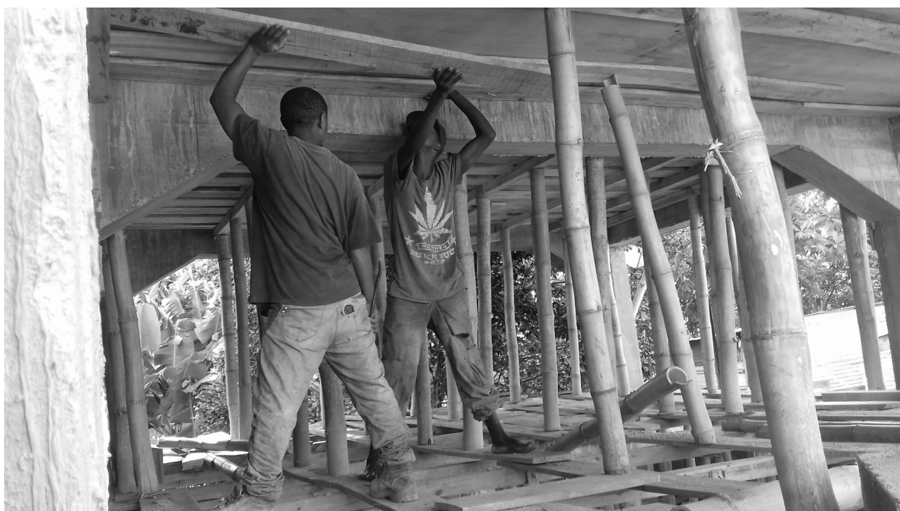
Fundi et Tavandaï retirent un chevron sous l'une des planches de coffrage. Le chevron dans le quart supérieur droit de l'image repose en équilibre sur un unique étais central, permettant de maintenir les planches de coffrage.
