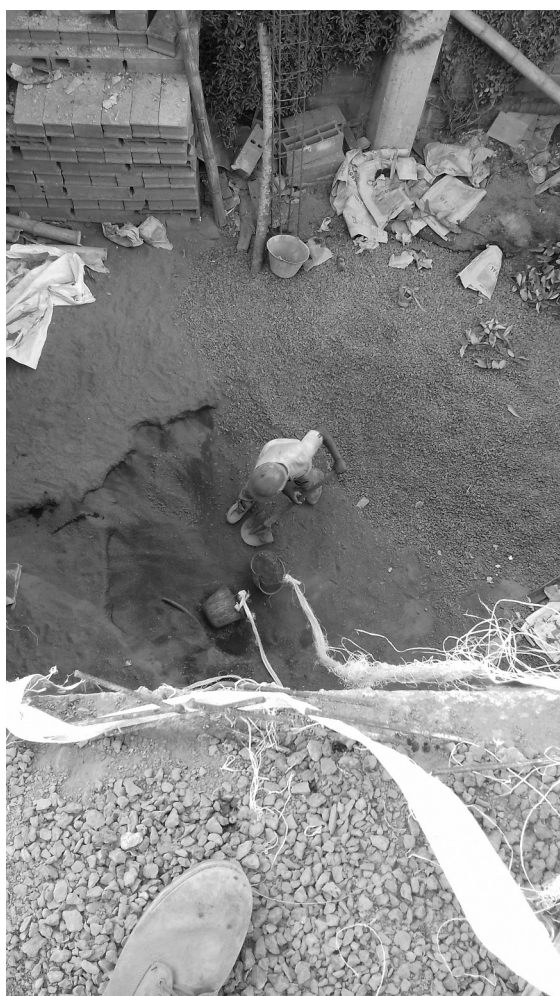
↑ M'Bolé et Tavandai montent les seaux fixés aux fibres plastiques sur le toit de la maison. ↓ Deux étages plus bas, Fundi remplit les seaux.
