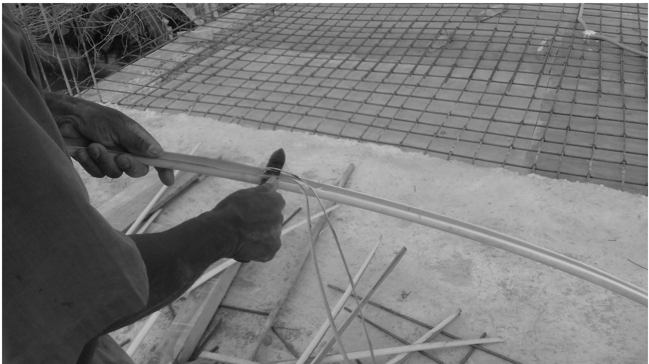
Bako taille des fibres de bananier pour réaliser des goulottes le long des avant-toits.
