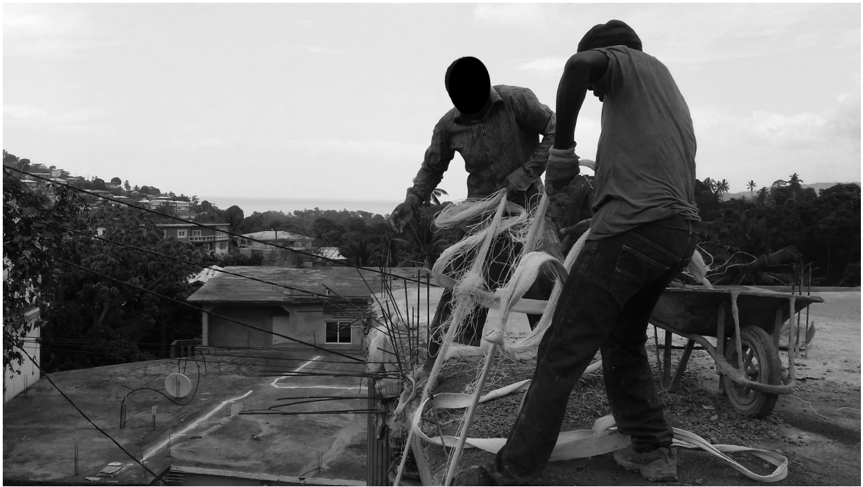
↑ M'Bolé et Tavandai montent les seaux fixés aux fibres plastiques sur le toit de la maison. ↓ Deux étages plus bas, Fundi remplit les seaux.
