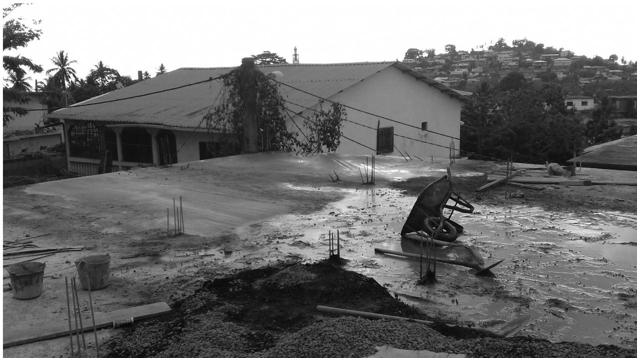
*La dalle terminée. Dans le quart inférieur droit : la partie humide est l'endroit sur lequel nous avons mélangé les différents matériaux pour obtenir le béton. Au premier plan : le sable et les cailloux non utilisés resteront sur le toit et seront utilisés plus tard pour construire le deuxième étage de la maison.*
