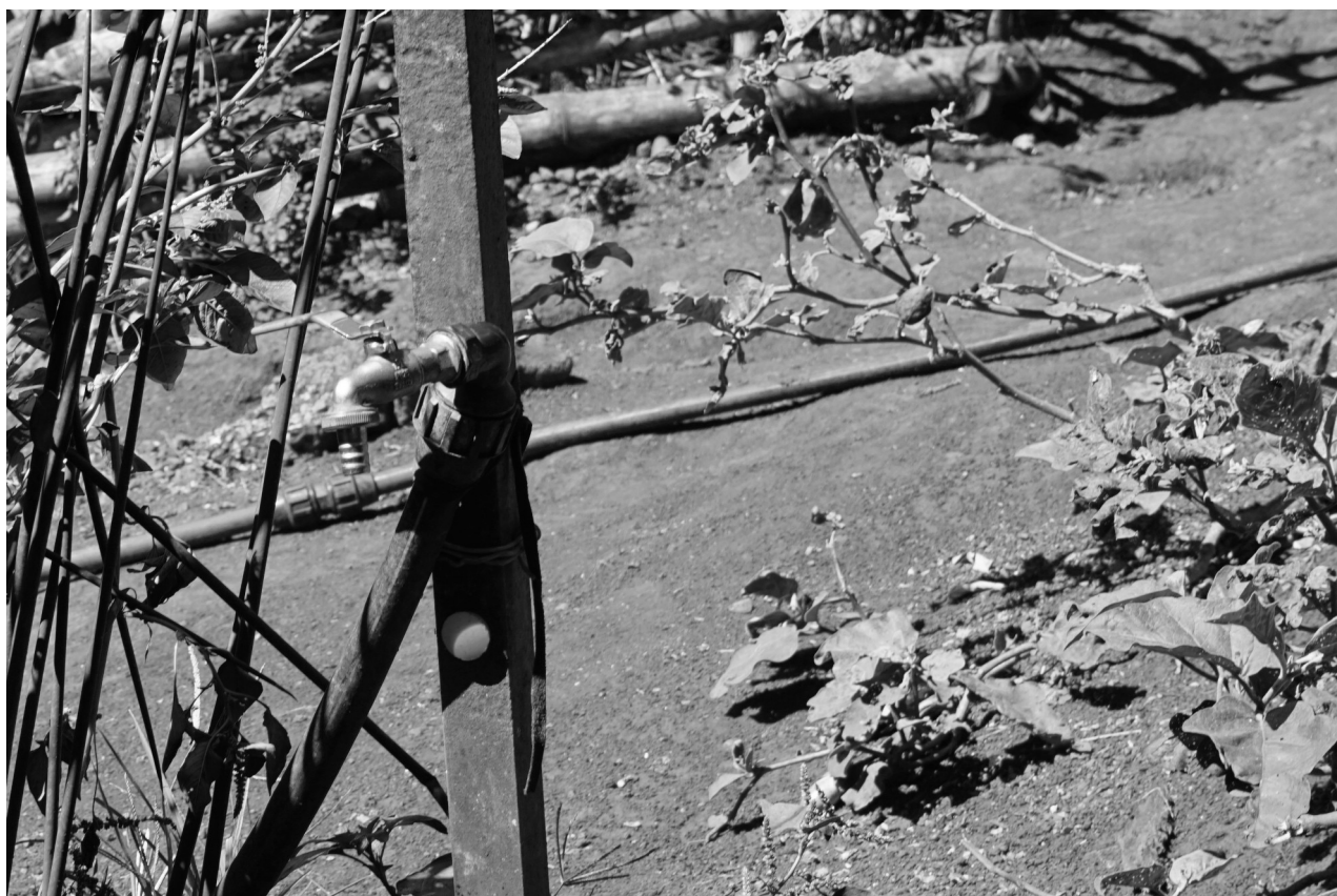
Robinet donnant un accès à l'eau dans le quartier de Gotham Au second plan : l'un des tuyaux d'irrigation du réseau en « spaghetti »
