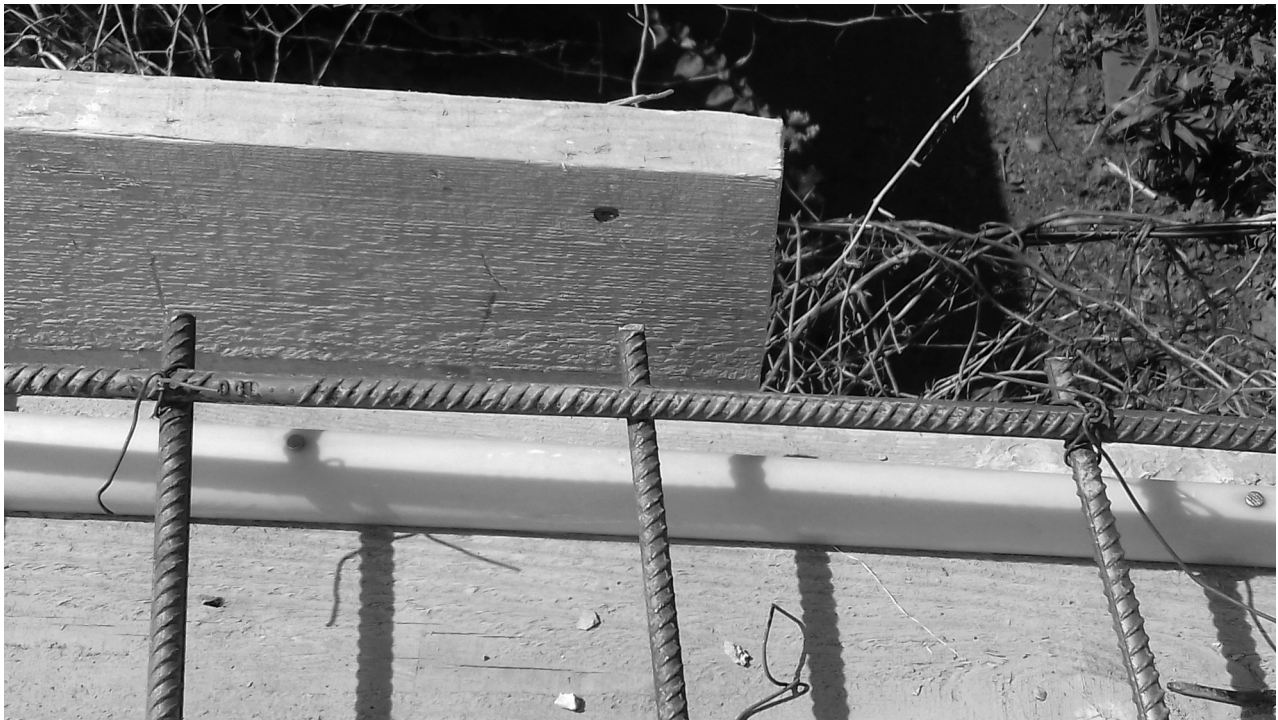
Une fibre fixée au niveau de l'avant-toit. Après avoir été coulée dans le béton, elle sera retirée pour former une goutte limitant les infiltrations d'eau.
