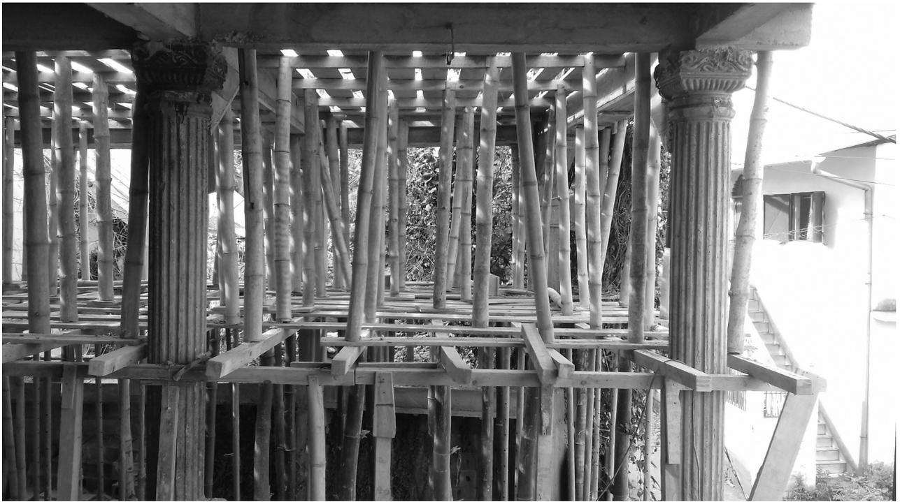
*Le second chafo une fois achevé. Il est constitué d'étais métalliques, d'étais de bambous secs issus du premier chafo, et d'étais de bambous verts ramenés par l'équipe du shibarwa. L'étage intermédiaire servira d'appui pour positionner les contre plaques constituant le fond du coffrage. La photographie a été prise au niveau du balcon du premier étage.*
