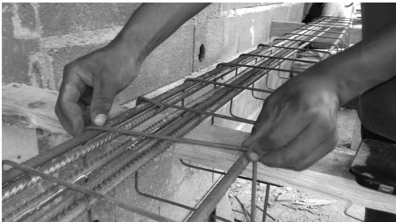
*Sous le regard de Bako, M'Bolé positionne les « triés » le long des tiges métalliques avant de les fixer. Les tasseaux qui constituent le cadre de bois sur lequel reposent les armatures sont directement insérés dans les parpaings de la maison.*
