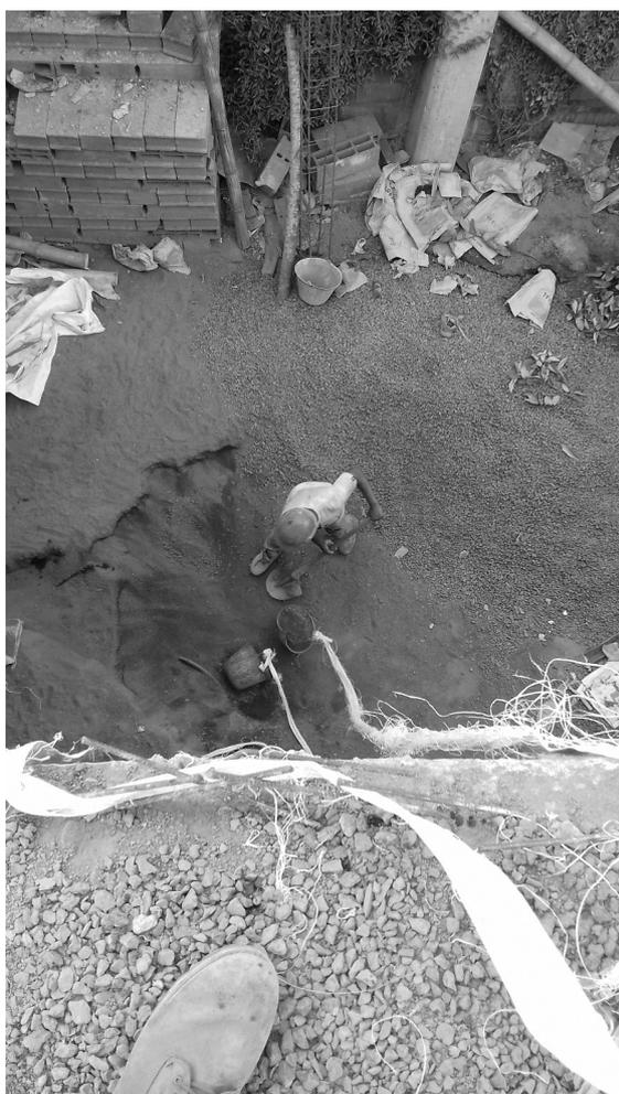
La dalle sur laquelle nous travaillons est hérissée de fers à béton qui seront utilisés plus tard pour joindre la dalle que nous devons réaliser à la construction déjà existante. Des fers verticaux sortent ça et là de la dalle : ils sont les parties émergentes du « *plan de ferrailage* » et seront utilisés a posteriori pour construire les pylônes porteurs du toit du deuxième étage.
