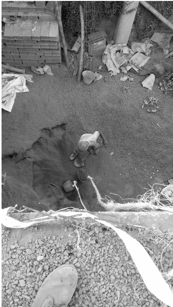
↑ M'Bolé et Tavandai montent les seaux fixés aux fibres plastiques sur le toit de la maison. ↓ Deux étages plus bas, Fundi remplit les seaux.
