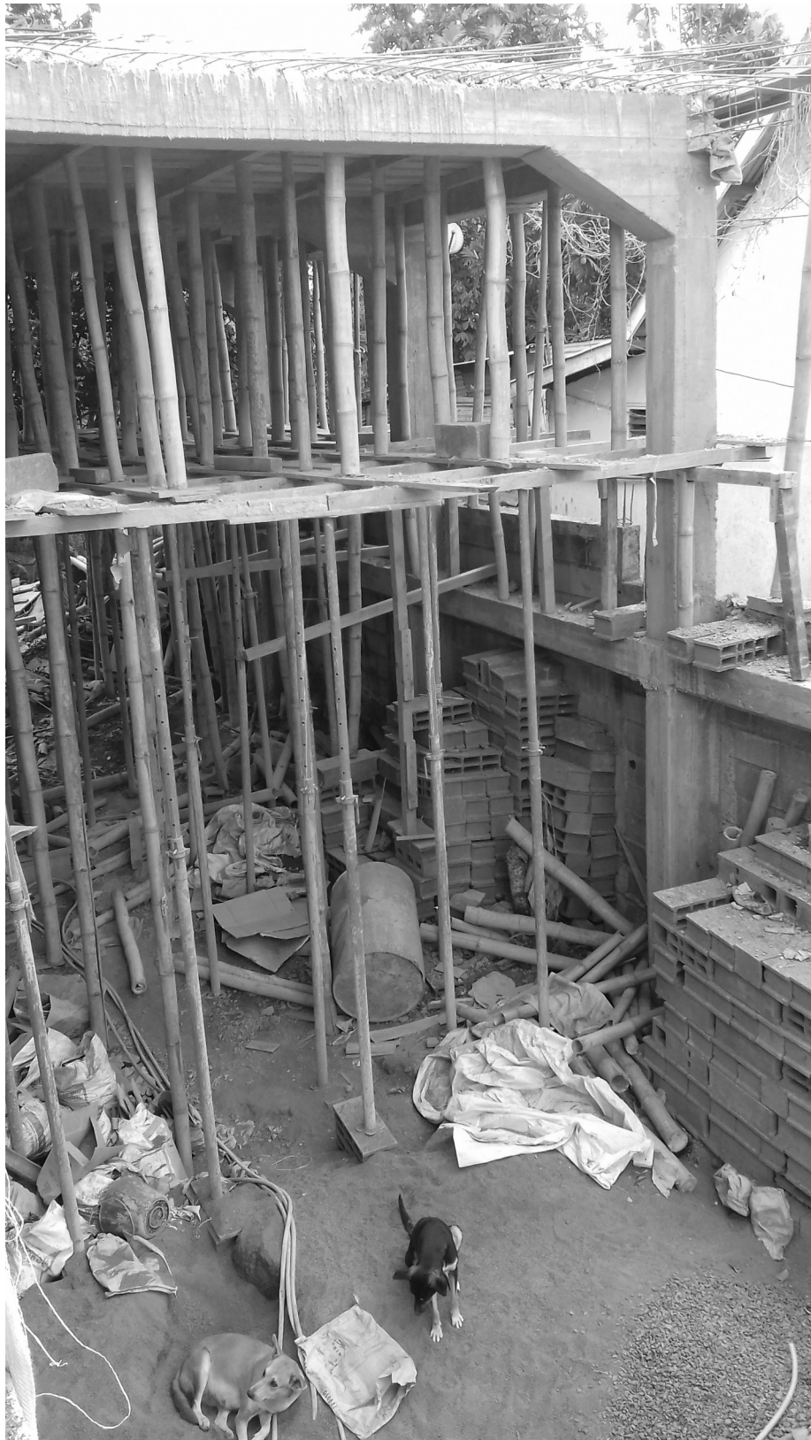
Le chafø de la premièrre partie de la dalle que nous devons d mønter : la partie inf rieure de l' chafaudage est constitu e d' tais m talliques et d' tais de bambou, l' tage interm diaire supporte une nouvelle s rie d' tais de bambou, plus courts, qui soutiennent les plaques de bois inf rieures du coffrage de la dalle.
