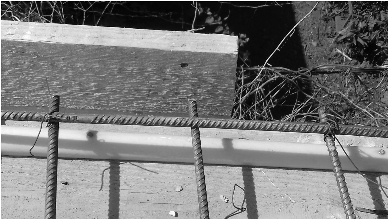
Une fibre fixée au niveau de l'avant-toit. Après avoir été coulée dans le béton, elle sera retirée pour former une goutte limitant les infiltrations d'eau.
