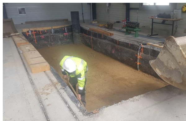
Figure II-2 : chaussée pendant son remplissage
