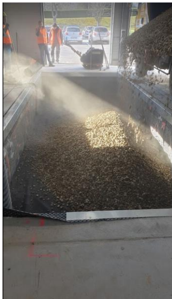
Figure II-3 : Mise en oeuvre du gravier de drainage dans la fosse
