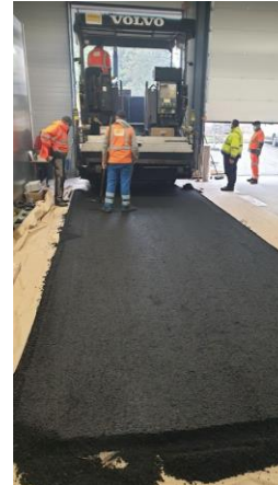
Figure II-17 : Mise en œuvre du BBAO
