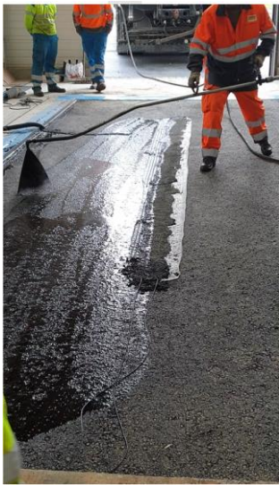
Figure II-10 : Mise en œuvre de la couche d'accrochage
