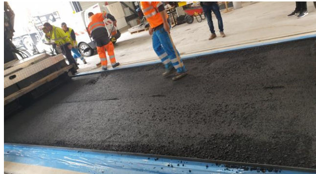
Figure II-7 : Mise en œuvre de la couche de GB dans la fosse
