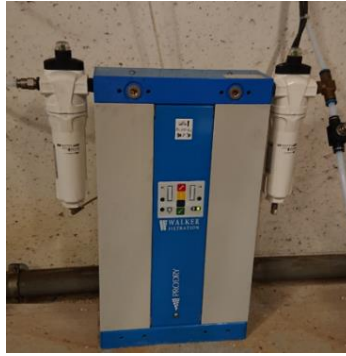
Figure II. 3: Dispositif sécheur d'air comprimé
