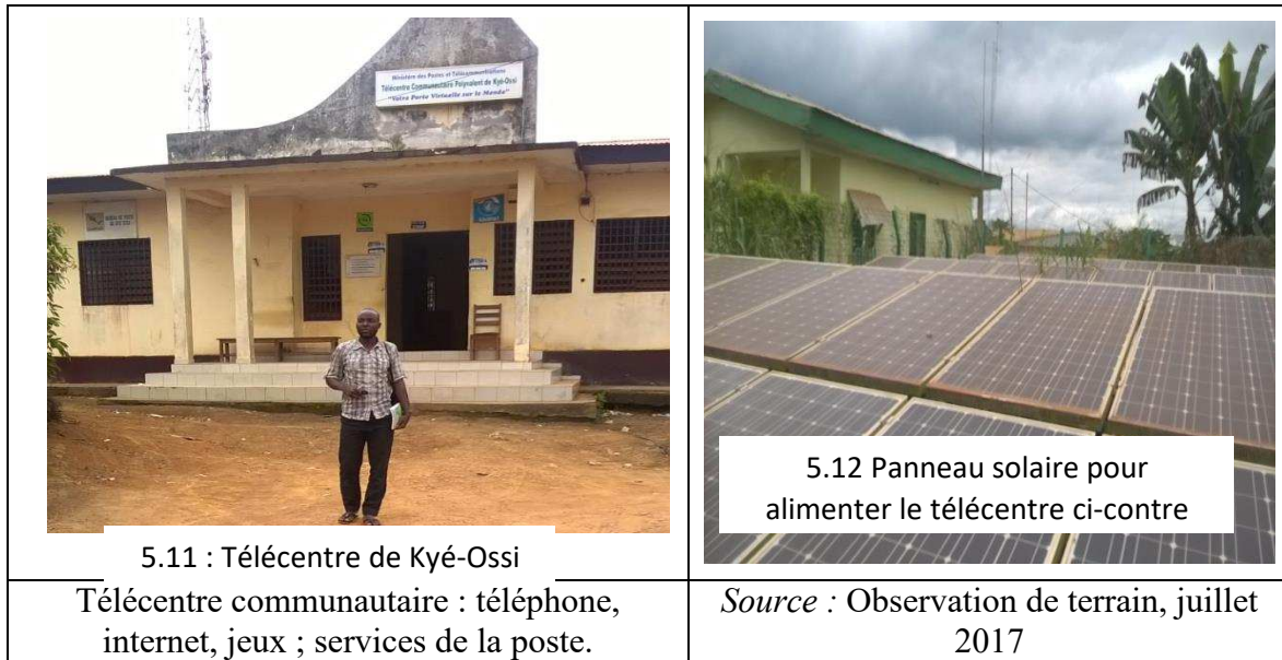
Photographies 5.11 et 5.12 : Infrastructures d'Etat
