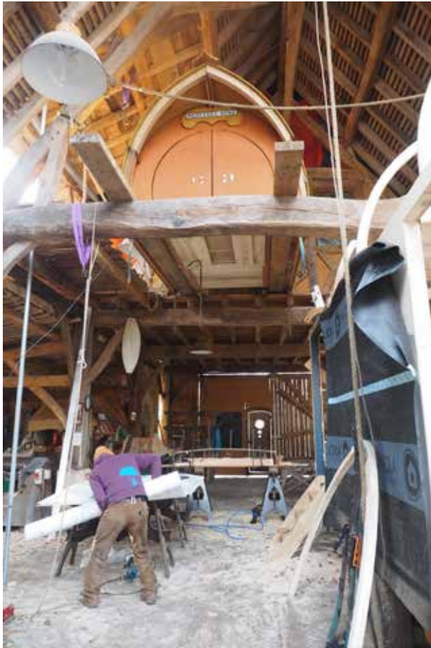
Intérieur de l'atelier de charpente, 2019
