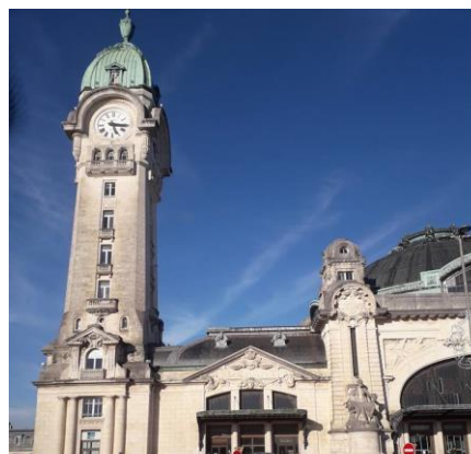
20 La gare de Limoges
