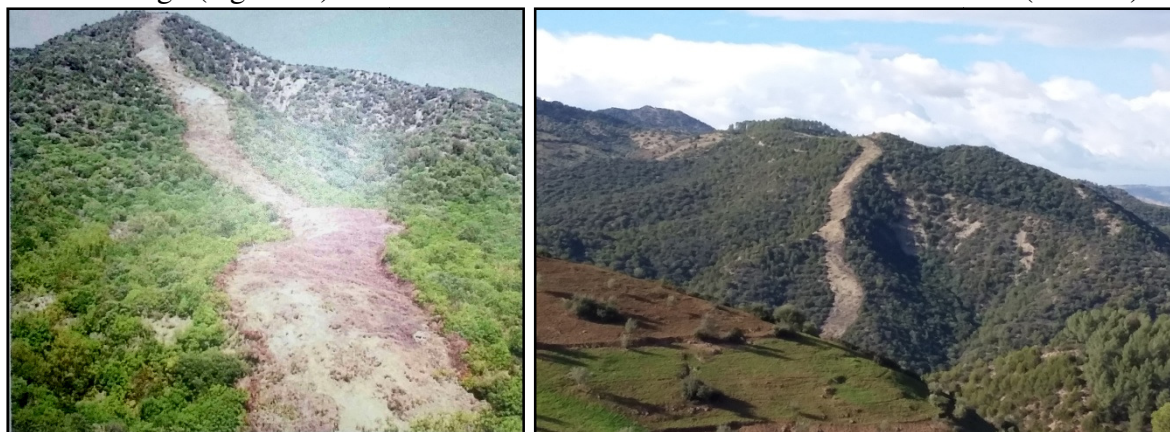
Photo 48 et 49 : Tranchée pare feu au canton de Droua Ben Hmada au commune rurale Ourtzagh (à gauche) et au canton Zbar Mchitau commune rurale de Galaz (à droite).
