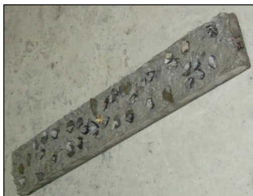
Figure IV-6: Support avec des granulats (Juarez et al., 2015)
