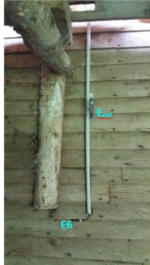
Figure IV-10 : Implantation des capteurs en surface et en ambiance extérieures en paroi nord
