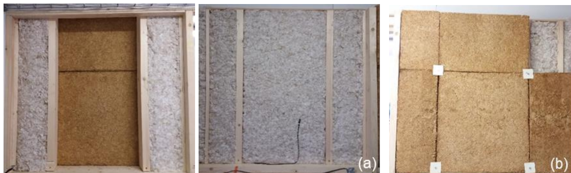
Figure II-18 : Mise en œuvre; (a) Isolant Biofib Trio, (b) Panneau en résidus de paille de colza
