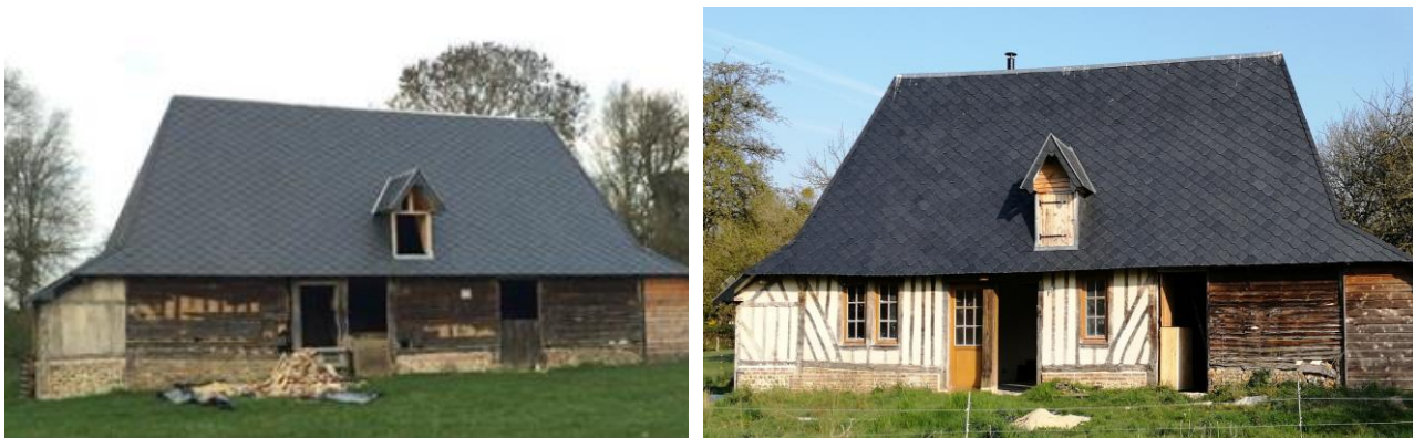
Figure IV-1 : Façade principale (Sud-sud est) du bâtiment avant et après rénovation
