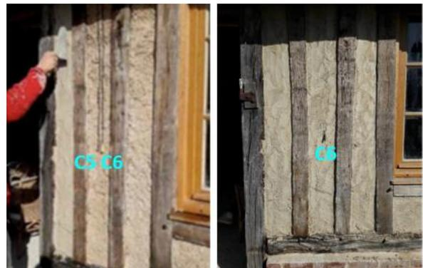
Figure IV-6 : Implantation des capteurs à l'interface béton de chanvre - enduit extérieur et en surface extérieure (en attente) en paroi sud
