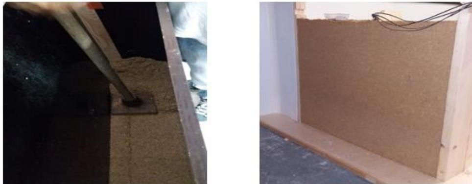
Figure II-10 : Mise en œuvre de la paroi terre-chanvre (gauche) et paroi démoulée avant enduit (droite)
