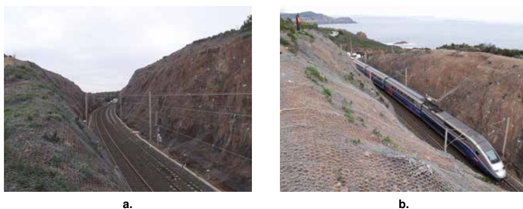
FIGURE I-3.5 – Exemple de tranchée rocheuse confortée par Grillage Plaqué Ancré - [Pollet, 2012]; (a.) Vue en bordure de la tranchée ; (b.) Vue depuis la crête
