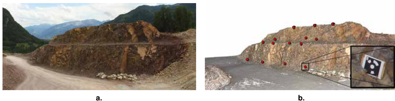
FIGURE A.6 – Carrière de Saint-Jeoire - Aperçu général du site et nuage de points - (a.) Vue sur les gradins étudiés depuis l'une des stations de scan ; (b.) Nuage de points 3D colorés issu du relevé lasergrammétrique. Les points rouges indiquent les positions des cibles utilisées comme points d'appui pour le relevé photogrammétrique.
