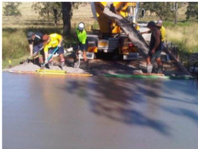
Figure I-22 : Pose de la chaussée légère à base de béton géopolymère [113].
