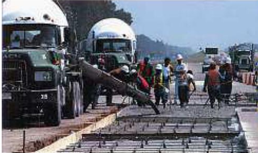
Figure I-21 : Rénovation de route avec le ciment Pyrament® ( www.geopolymer.org ).
