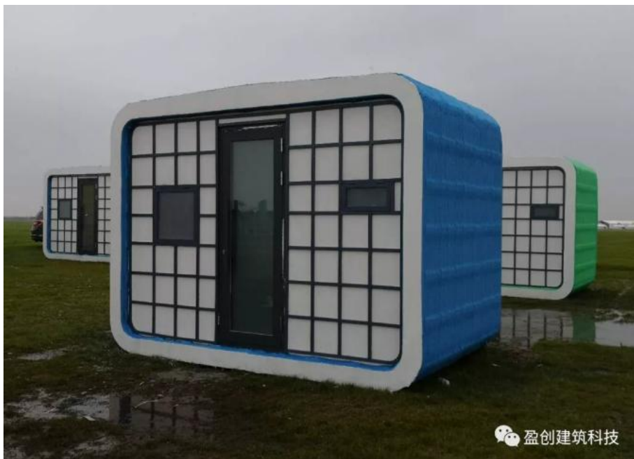
Figure 4 : Cabines de quarantaine imprimées en 3D par la société Winsun en Chine [7]
