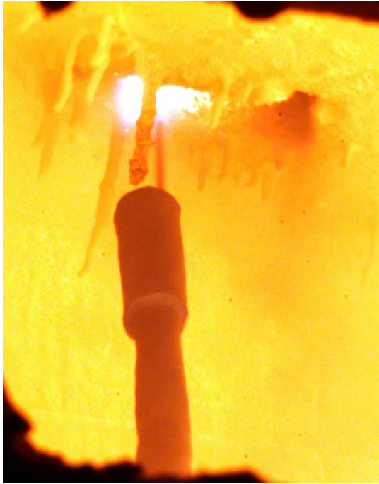
Figure I-31. Tige de soudage utilisée lors de travaux de réparation d'une céramique réfractaire employée dans les fours verriers industriels [56].
