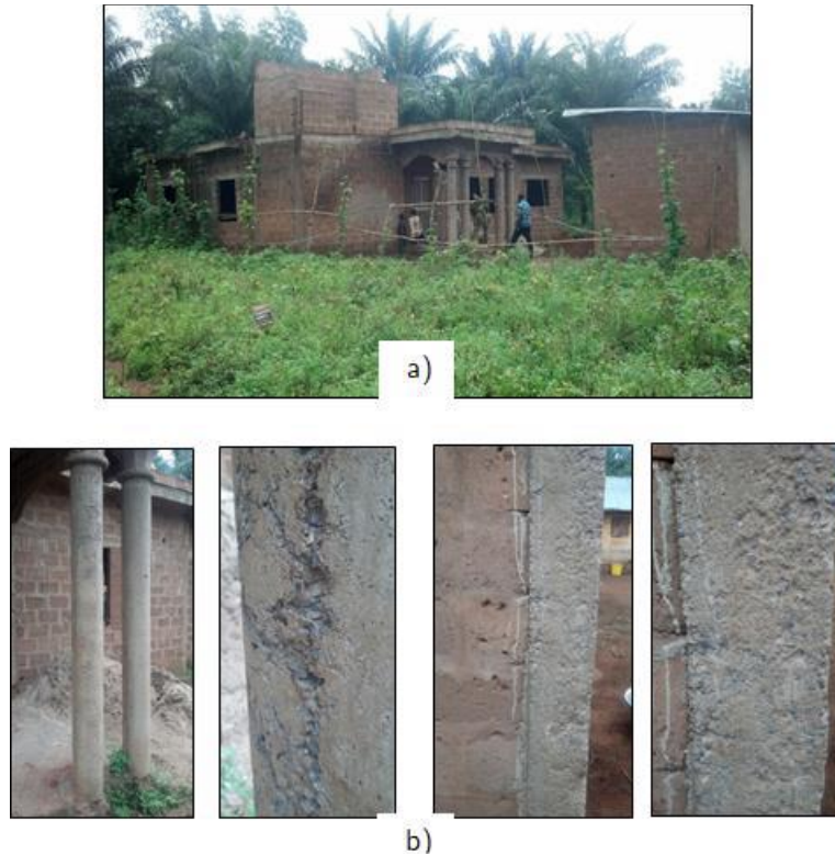
Figure 14 : Bâtiment en BCNP à Missérétié (Bénin) a) vue d'ensemble du bâtiment b) Poteaux et raidisseurs faisant apparaître le BCNP (Godonou, 2019)
