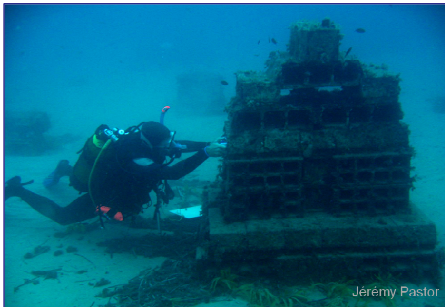
Figure 7. Récif artificiel d'émancipation constituée uniquement de loges de très petite taille pour servir de refuge aux poissons juvéniles, utilisée dans le cadre de projets de repeuplement, comme celui-ci de Monaco (© Jérémy Pastor).
