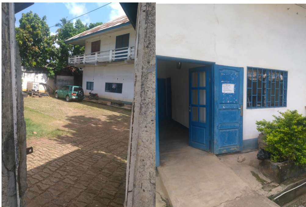
Encadré : photos service public d'eau à Ebolowa
