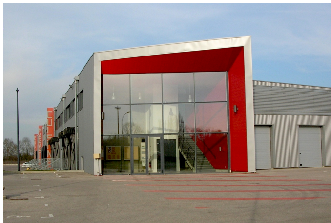
FIGURE 1.9 – Unité centrale de production alimentaire du CHT.
