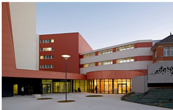
FIGURE 1.1 – Entrée du nouveau bâtiment d'accueil du CHT.
