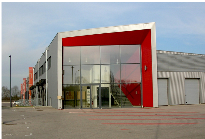
FIGURE 1.9 – Unité centrale de production alimentaire du CHT.
