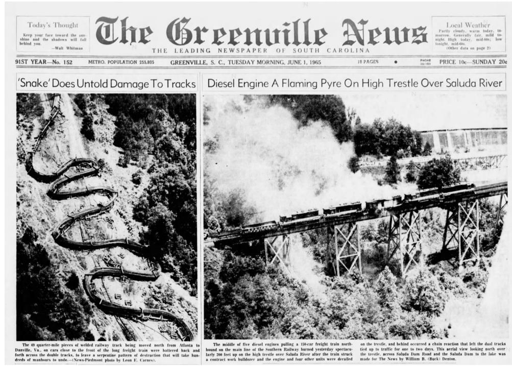
Figure 5.2: Photos de l'accident ferroviaire de Greenville (Caroline du Sud), le 31 mai 1965. Suite au déraillement en tête de convoi (photo de droite), le chargement de barres d'acier situé plus à l'arrière a adopté une configuration conservant sa longueur initiale mais minimisant la courbure totale, suivant une courbe de type méandre (photo de gauche).
