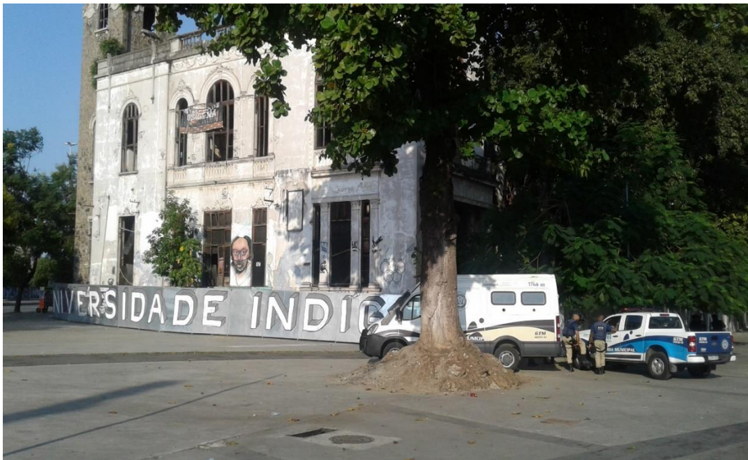
Figure 6,5 : Bâtiment de l'ex-Museu do Índio à l'Aldeia Maracanã
