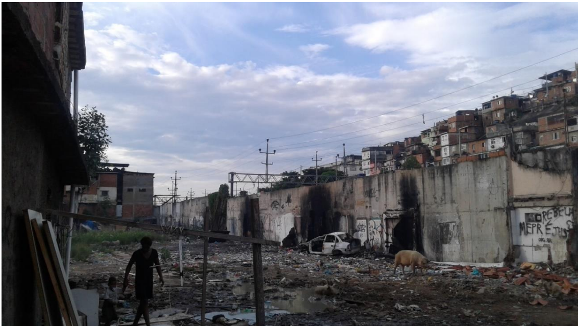
Figure 6,44 : Scénario de destruction après les expulsions dans la favela de Metrô-Mangueira
