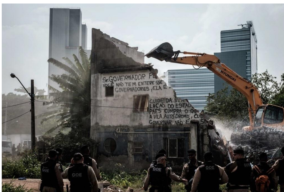
Figure 5,1 : Démolitions à Vila Autódromo
