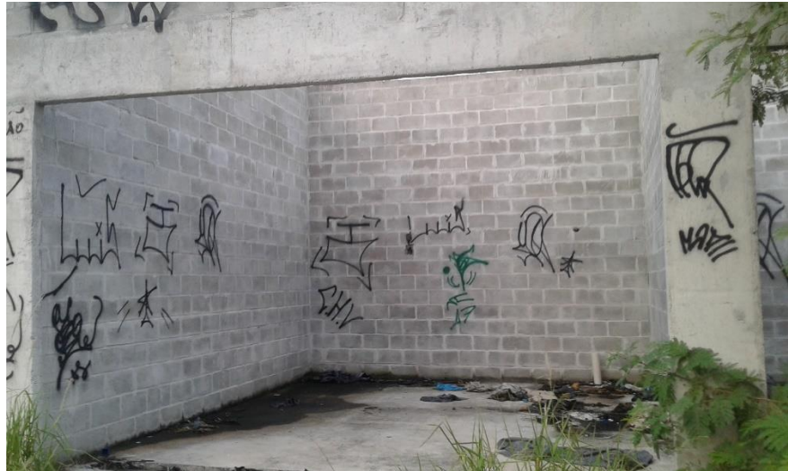
Figure 6,42 : Box abandonnées construits par la Mairie
