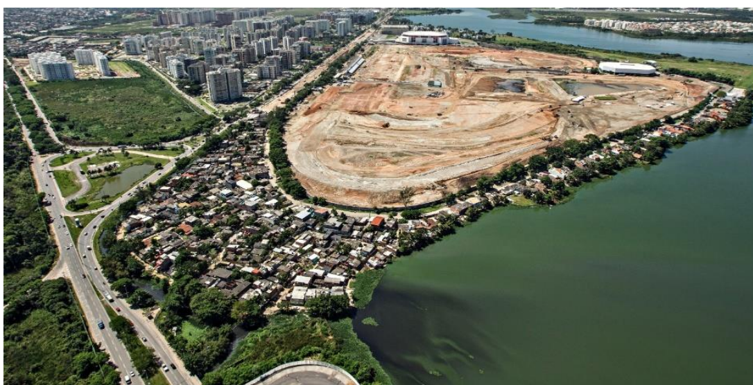
Figure 6,12 : Image aérienne de Vila Autódromo avant les travaux du parc olympique
