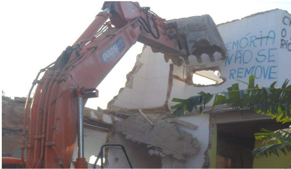
Figure 6,14 : Démolitions à la Vila Autódromo
